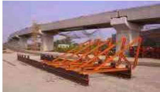
沙崙計畫高架橋預力樑吊裝完成
