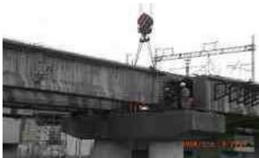
龍恩堰懸臂橋吊樁施工
