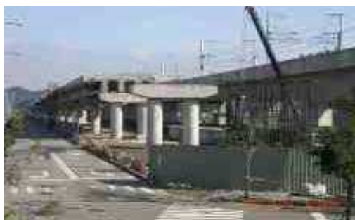
龍恩堰懸臂橋吊樁施工
