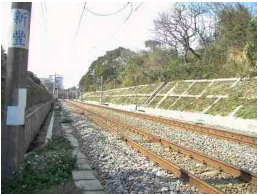
新豐站南護坡、排水溝等景觀改善工程(圖一)
