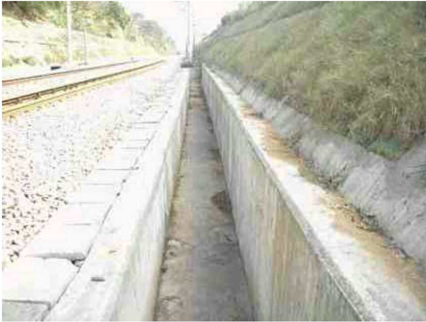
新豐站南護坡、排水溝等景觀改善工程(圖二)
