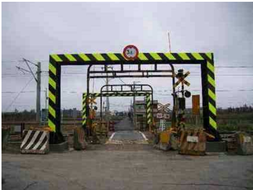
苗栗等站圍籬新建及改善工程(圖一)
