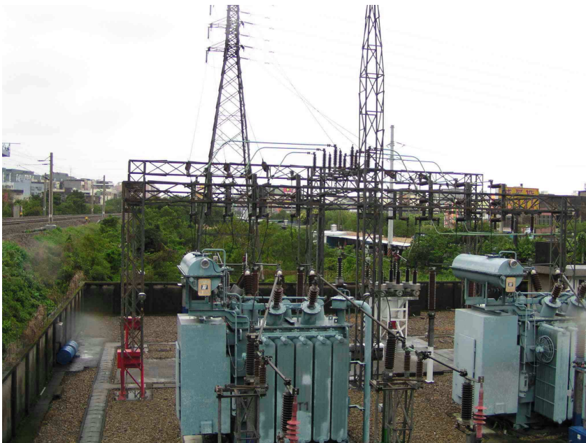
（69KV 輸電線路-鐵壠線）
