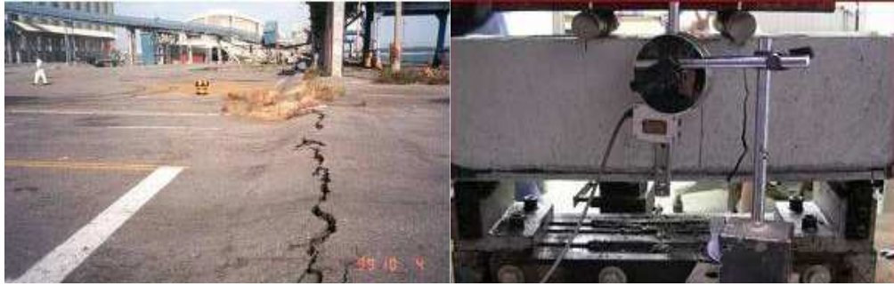
(3) 重力式碼頭損壞異象例 (4) RPC 補強混凝土試體抗彎試驗
