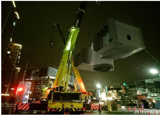
三峽三樹路 P05-27 鋼帽梁吊裝
