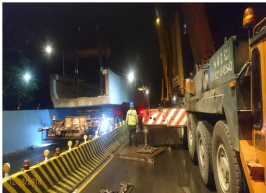
三峽隆恩街 P07-30~P07-31 上構預鑄 U 型梁吊裝
