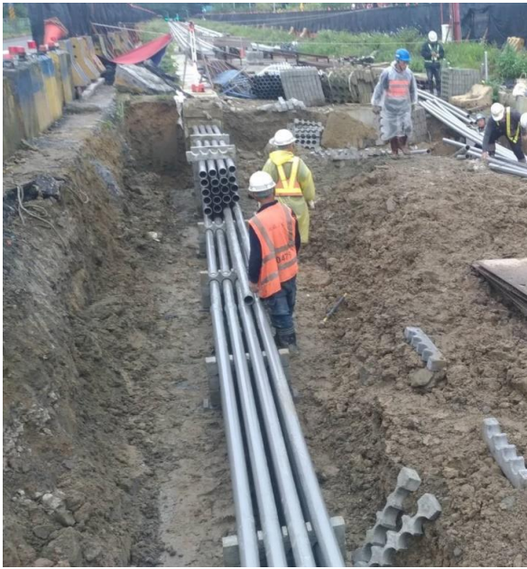
電纜管道、手孔埋設
