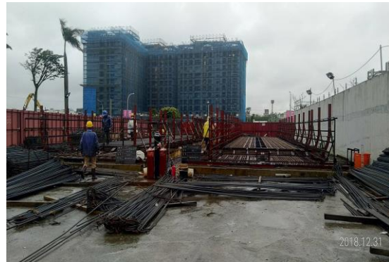
預鑄梁場 P07-03~P07-04(上下行線) 預鑄上構 U 型梁鋼筋組立
