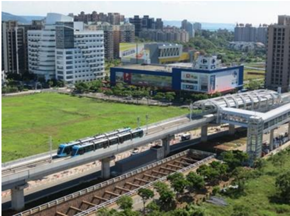
綠山線 V07 高架站
