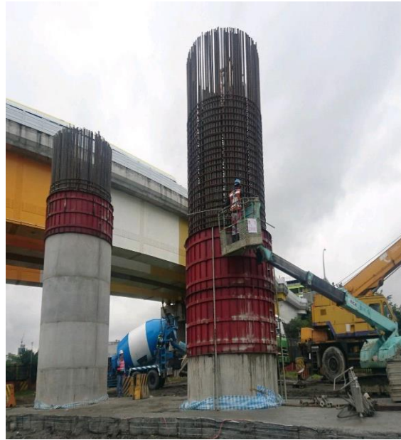
P9-17 墩柱 2 第五層混凝土澆置
