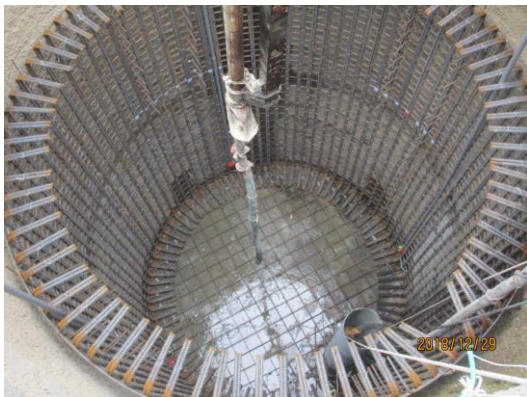
三峽復興路 P07-02 井式基礎混凝土澆置
