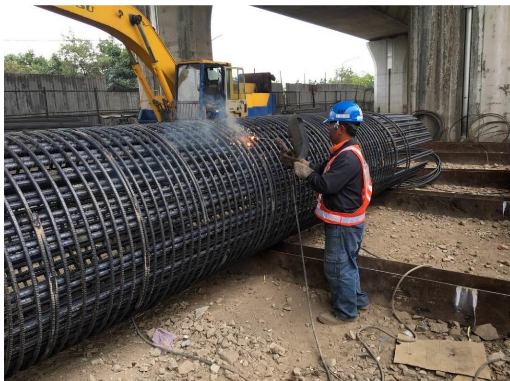
第M37D標 南投高架橋鋼筋籠焊接作業
