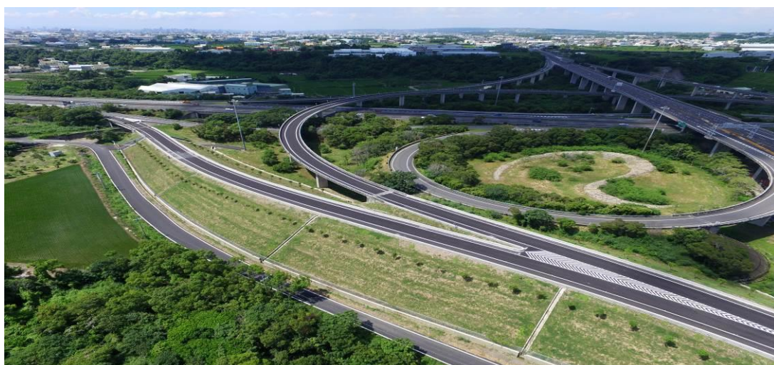
第 I14 標 北側匝道 R4 及 R7 竣工
