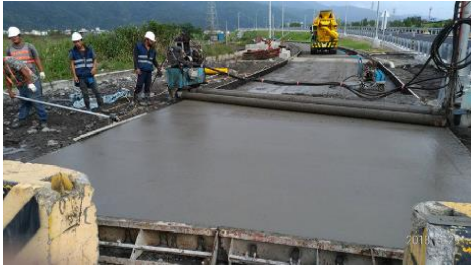
第 E14 標 農路 FP30-1 剛性路面混凝土鋪築
