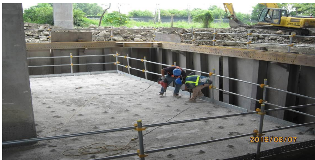
第 M41 標 P42R 基礎植筋鑽孔
