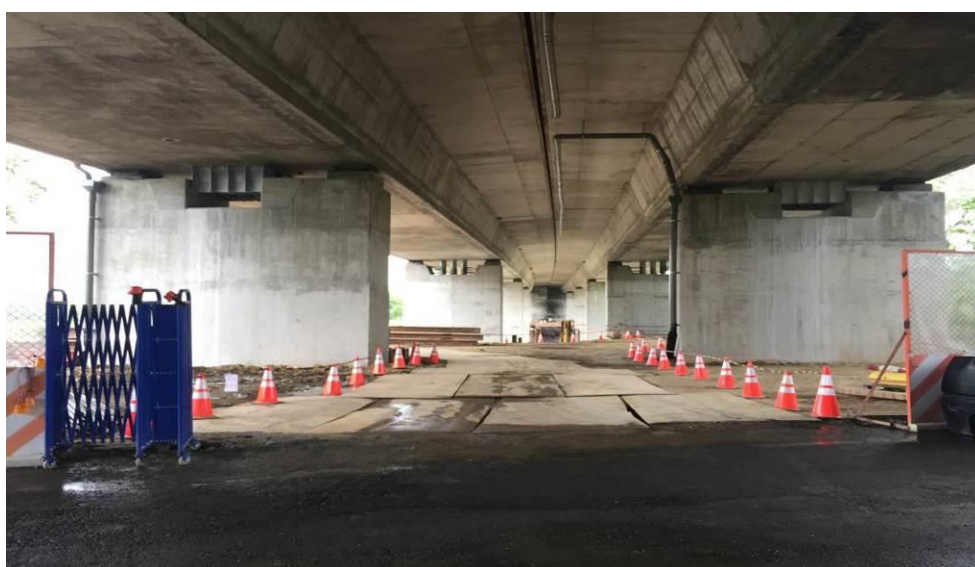
第M37A標 大湖口溪排水橋P4增設剪力樺施工
