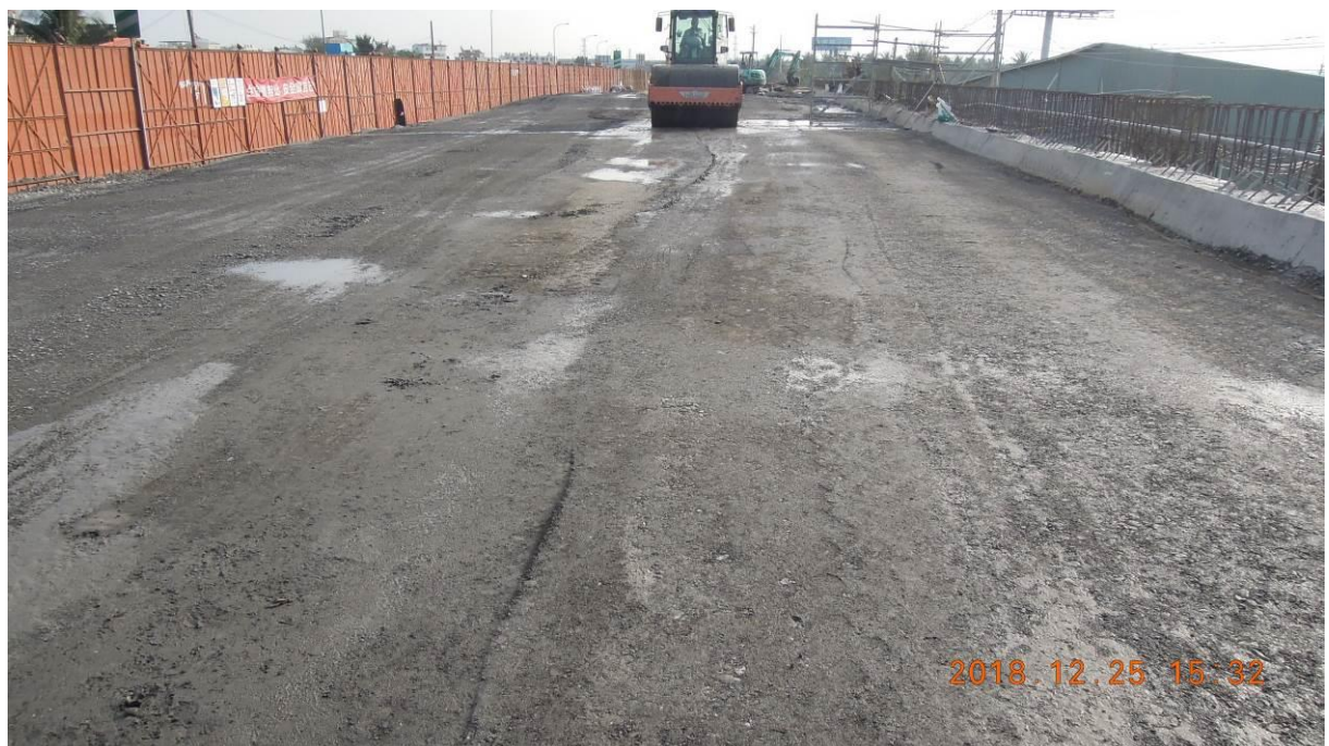
第5A1標 高速公路主線級配粒料底層之鋪築與整平
