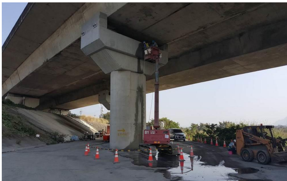
第 M37C1 標 液態阻尼器安裝前鑽孔
