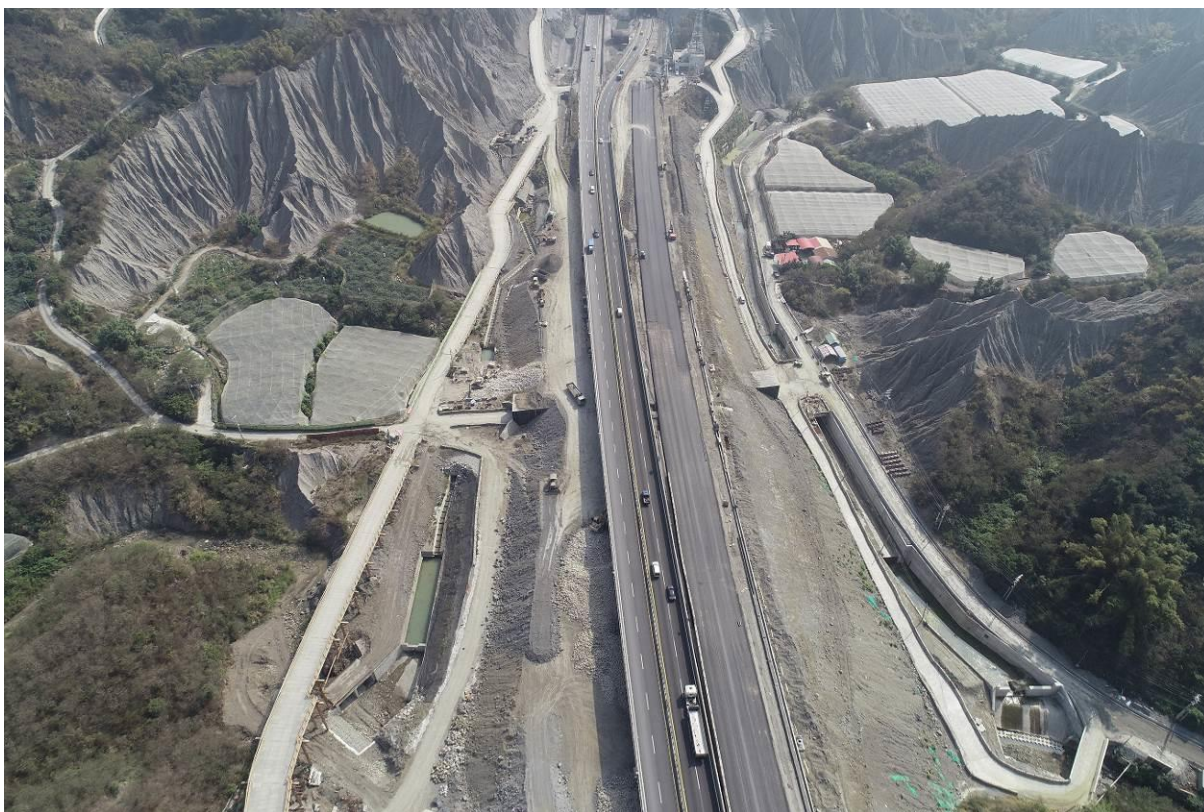
第 D11 標 中寮隧道路堤施工空拍圖
