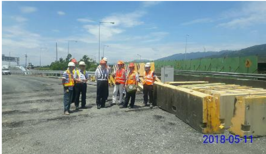
高公局趙興華局長視察 E14 標工地
