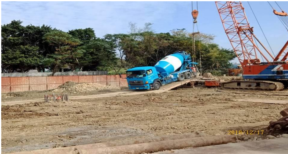
第 H72 標 EBP5L#2 全套管基樁混凝土澆置
