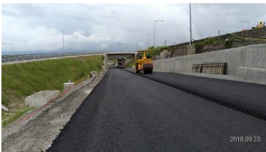
第 E14 標 匝道 L2 路堤段瀝青處理底層鋪築
