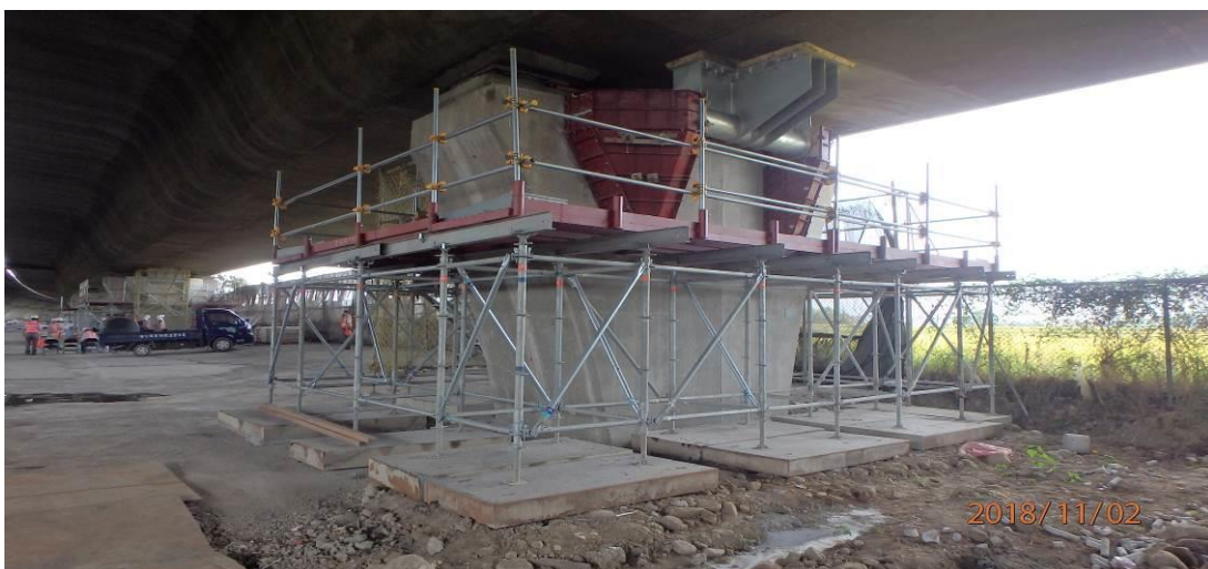
第 M37E 標 霧峰高架橋 P57 鋼止震施工
