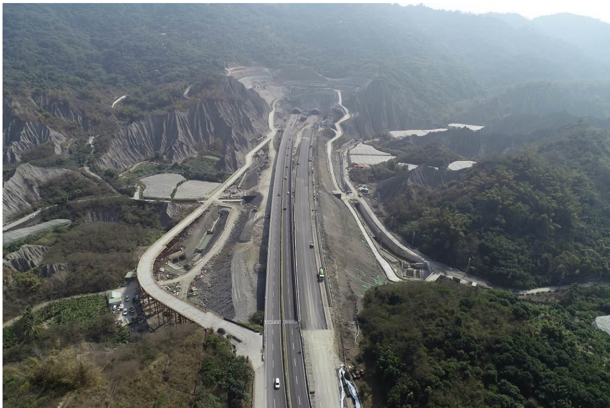
第 D11 標 中寮隧道改善工程施工空拍圖
