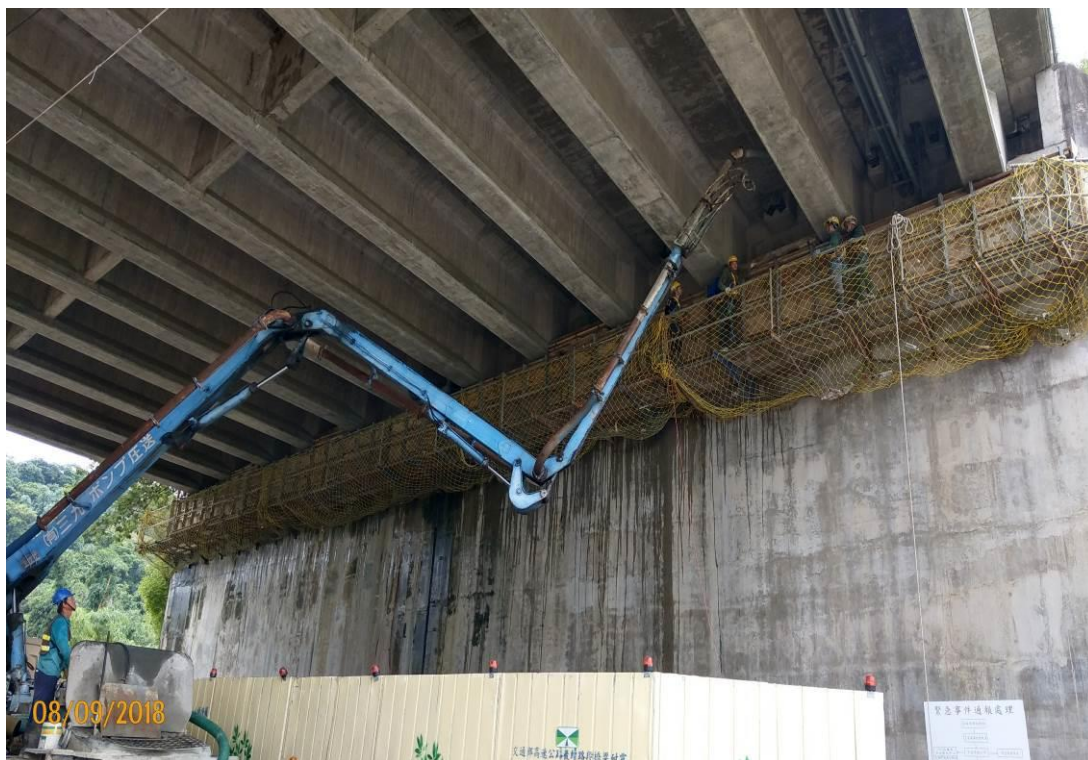
第 M37C2 標 斗六大圳 2 號橋 A2 橋台澆置
