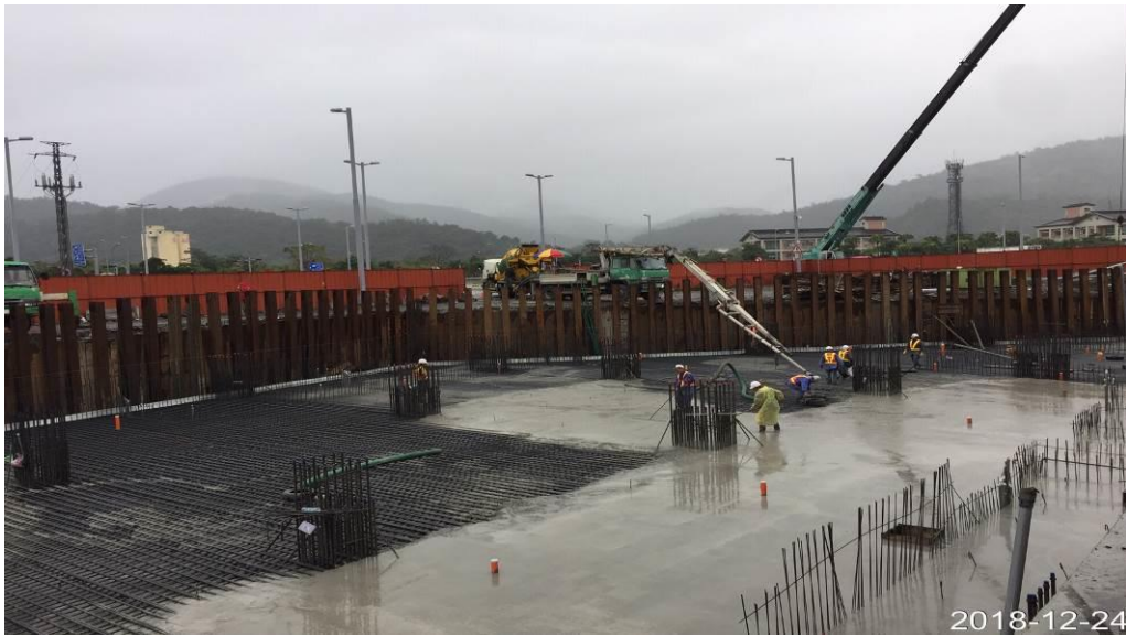
第 E252 標 服務中心地下一層基礎灌漿
