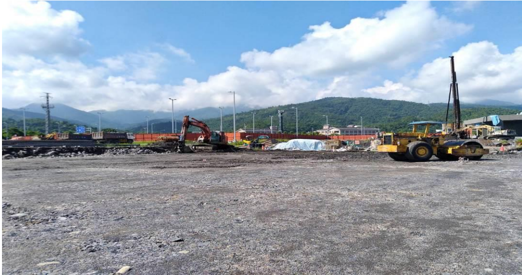
第 E252 標 東側廁所基礎底整地夯實
