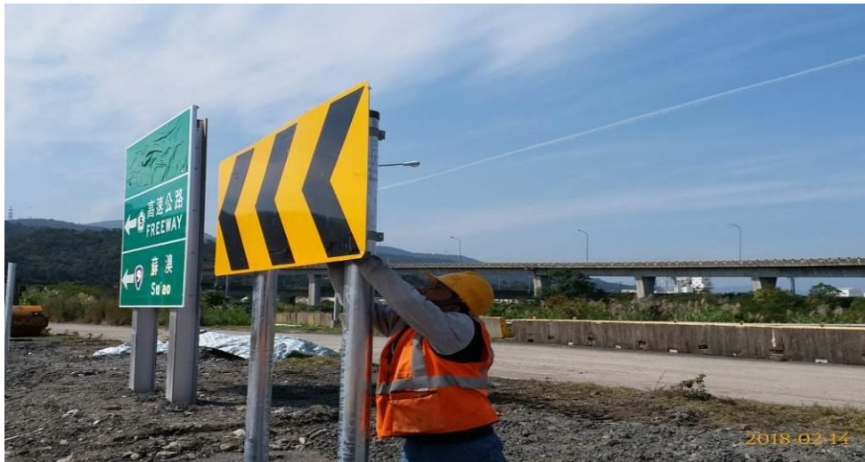
第 E251 標 停車場導引牌面安裝
