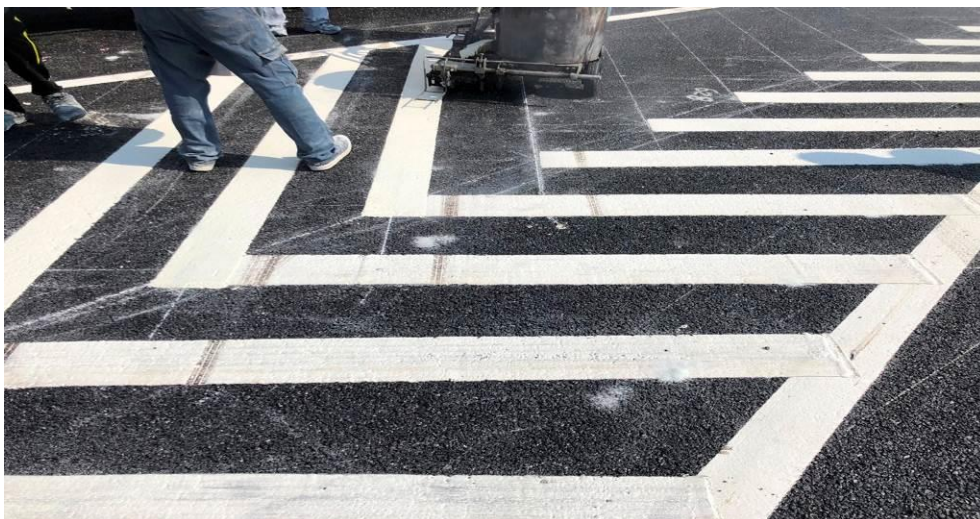
第 E251 標 離場道路標線繪製
