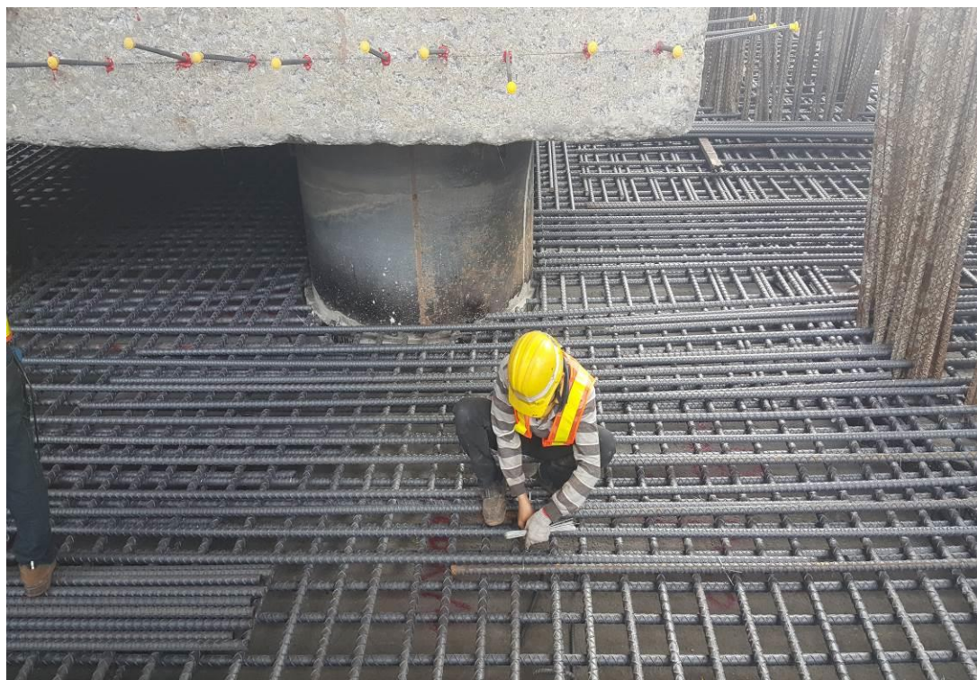
第 M37C1 標 基礎鋼筋綁紮
