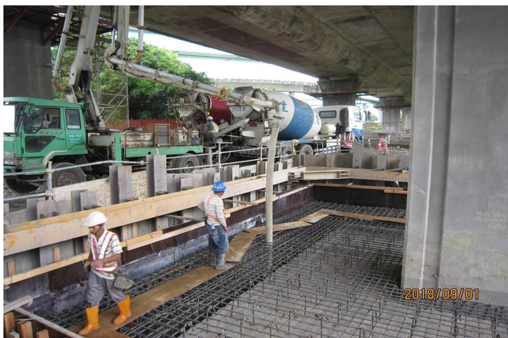
第 M41 標 P44R 基礎 SCC 混凝土澆置
