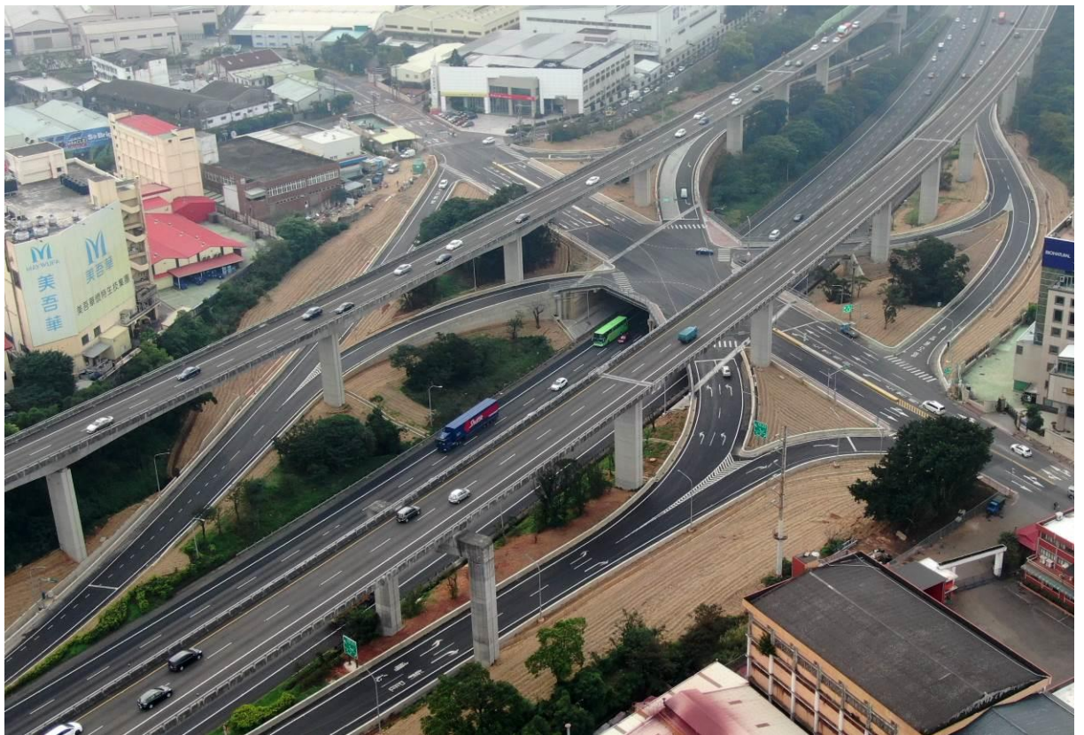
第 214 標 完工後之空拍照
