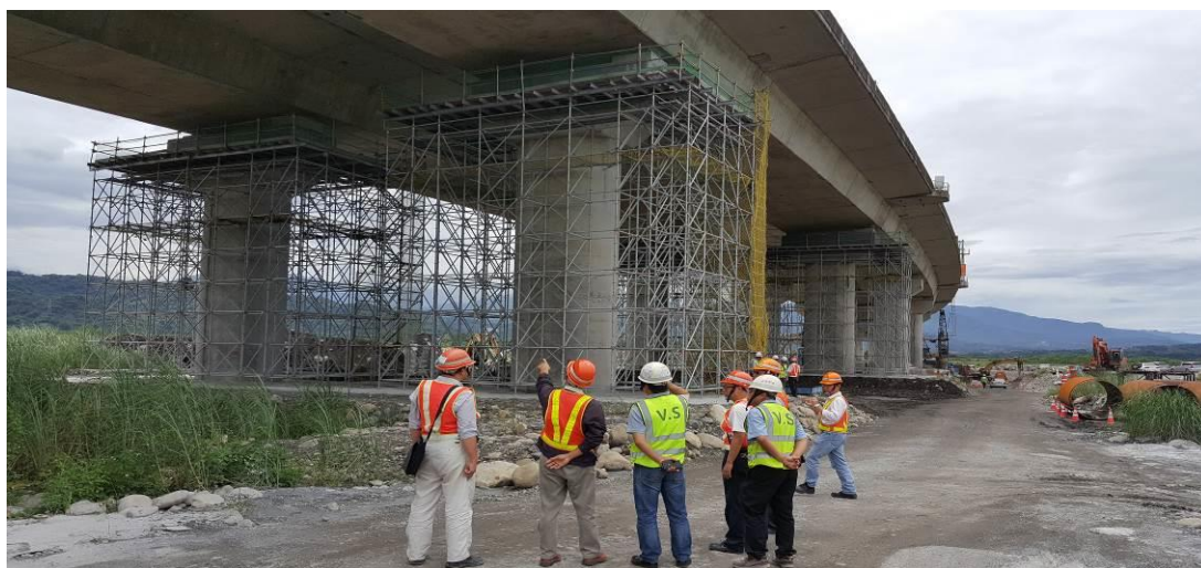
第 M37C1 標 高公局黃裔炎副總工程司視察工地
