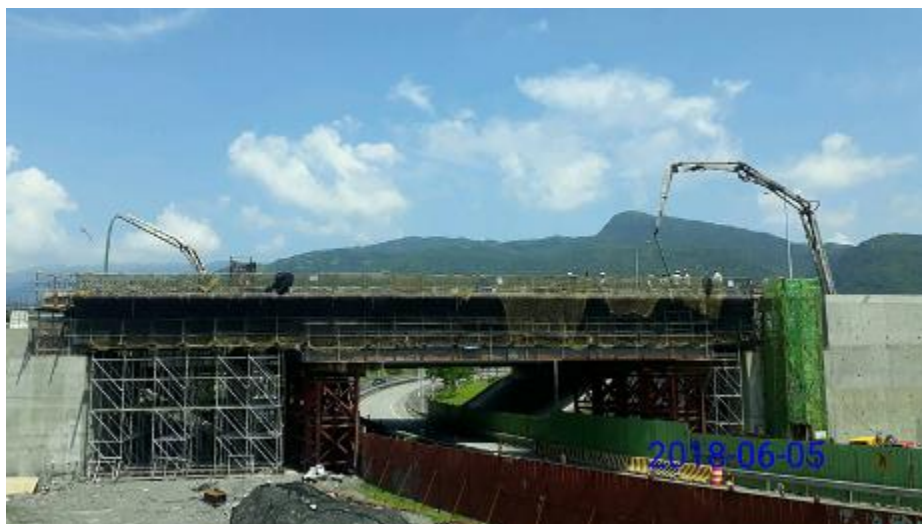
第 E14 標 匝道 L2 穿越橋箱型梁腹頂版混凝土澆置
