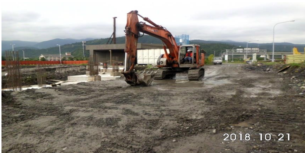
第 E252 標 環場道路路基整地
