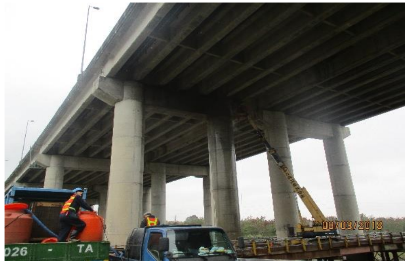
第 M37B 標 八掌溪河川橋帽梁表面水刀處理
