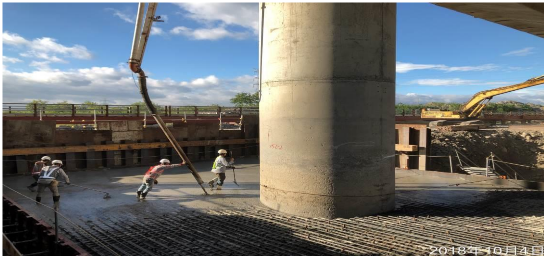
第 M37E 標 烏溪三號橋 P52R 基礎澆置
