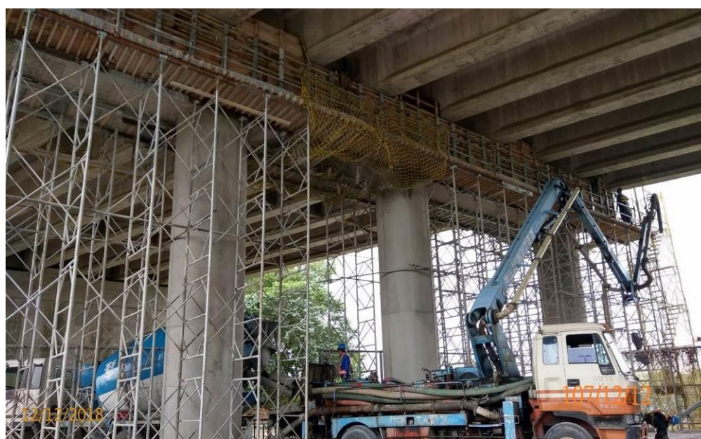
第 M37C2 標 楓樹湖南溪 P1 帽梁(含止震塊)澆置
