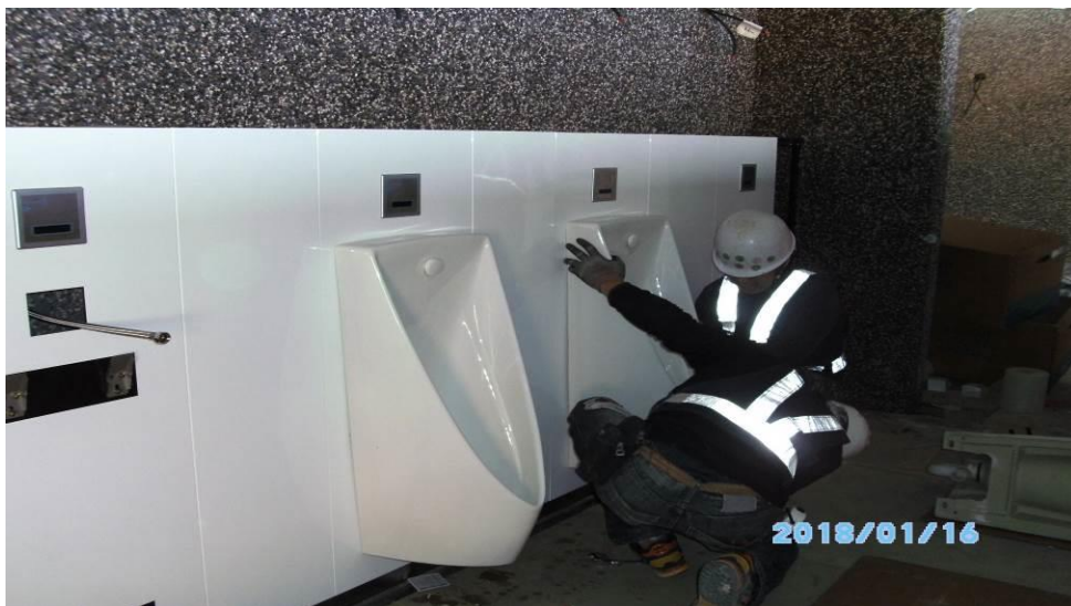
第 E251 標 西側廁所小便器安裝
