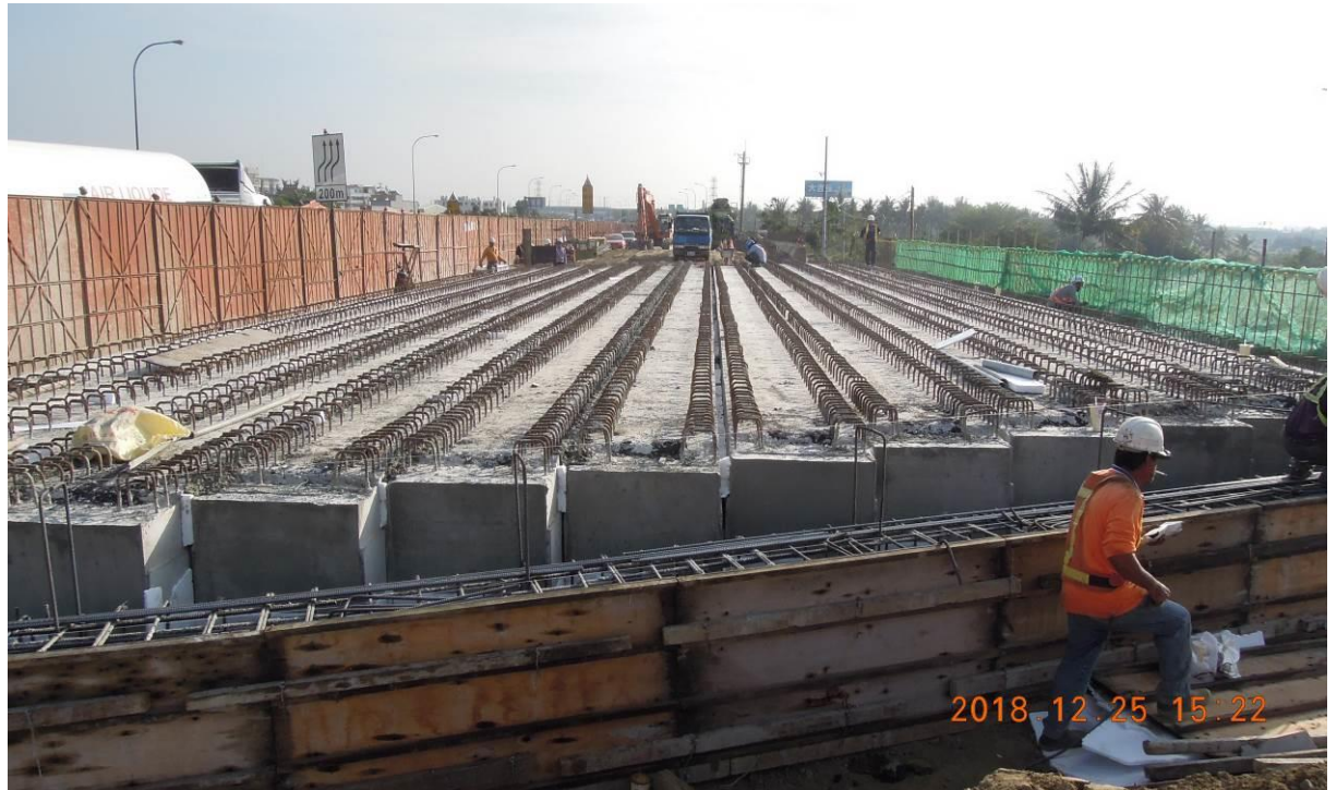
第5A1標 簡支密排預力中空板梁施工
