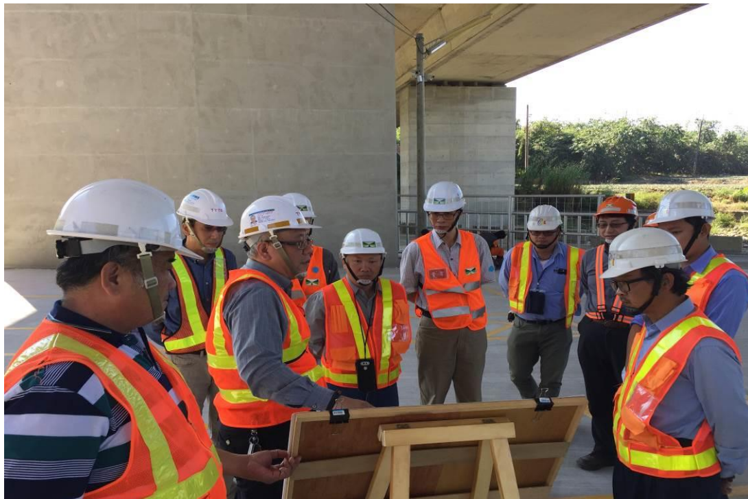
第M37A標 崙子溪河川橋簡易水保完工檢查
