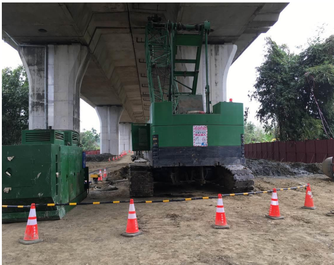
第 M37D 標 南投高架橋全套管基樁施工
