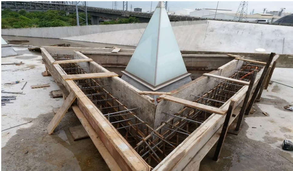
第 E251 標 西側廁所屋頂景觀座椅鋼筋模板組立
