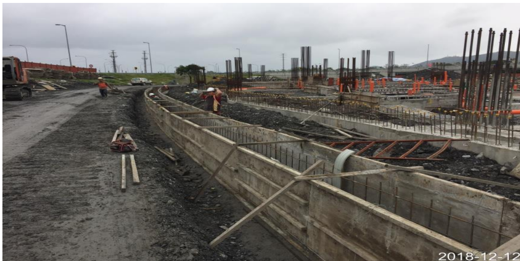
第 E252 標 周邊水溝(UA502 水溝)模板組立
