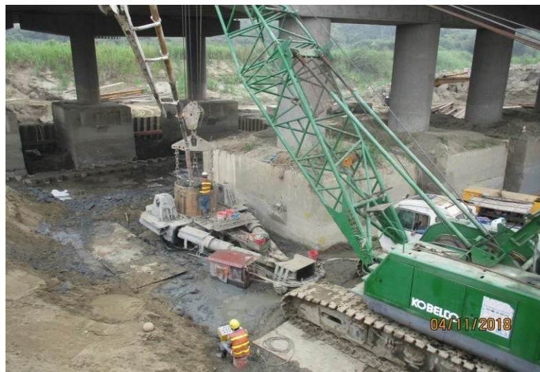
第 M37B 標 龜重溪橋全套管基樁 P5R5 施作
