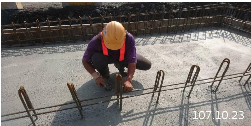
第 E252 標 洗車台鋼筋組立施工
