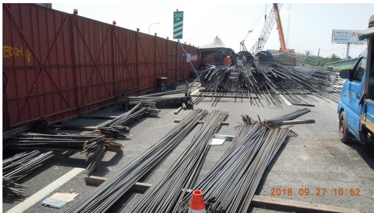
第5A1標 基樁鋼筋籠施工
