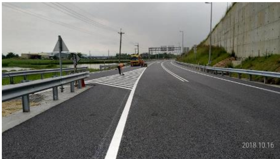
第 E14 標 匝道 L2 路面槽化標線標繪
