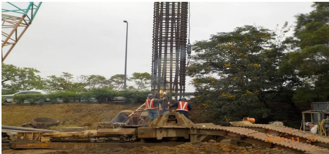
第 M37E 標 中興交流道基樁施工
