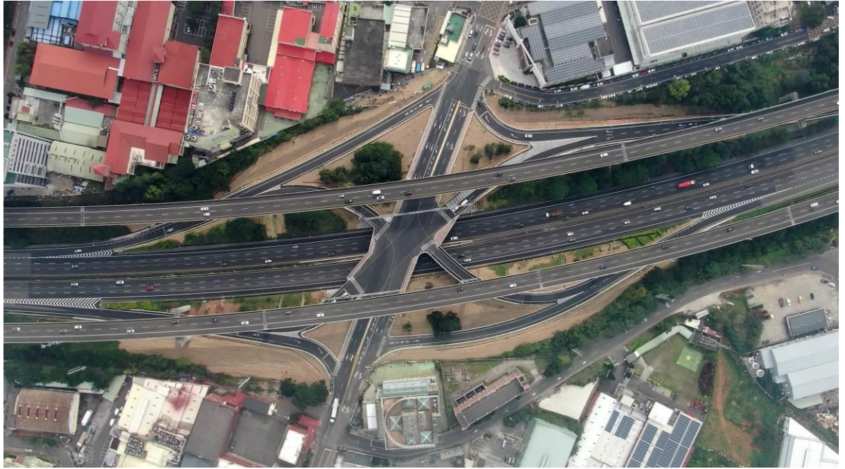
第 214 標 完工後之空拍照
