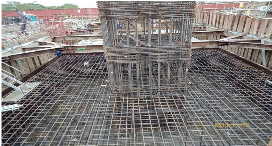
第 H72 標 EBP11R 基礎鋼筋綁紮
