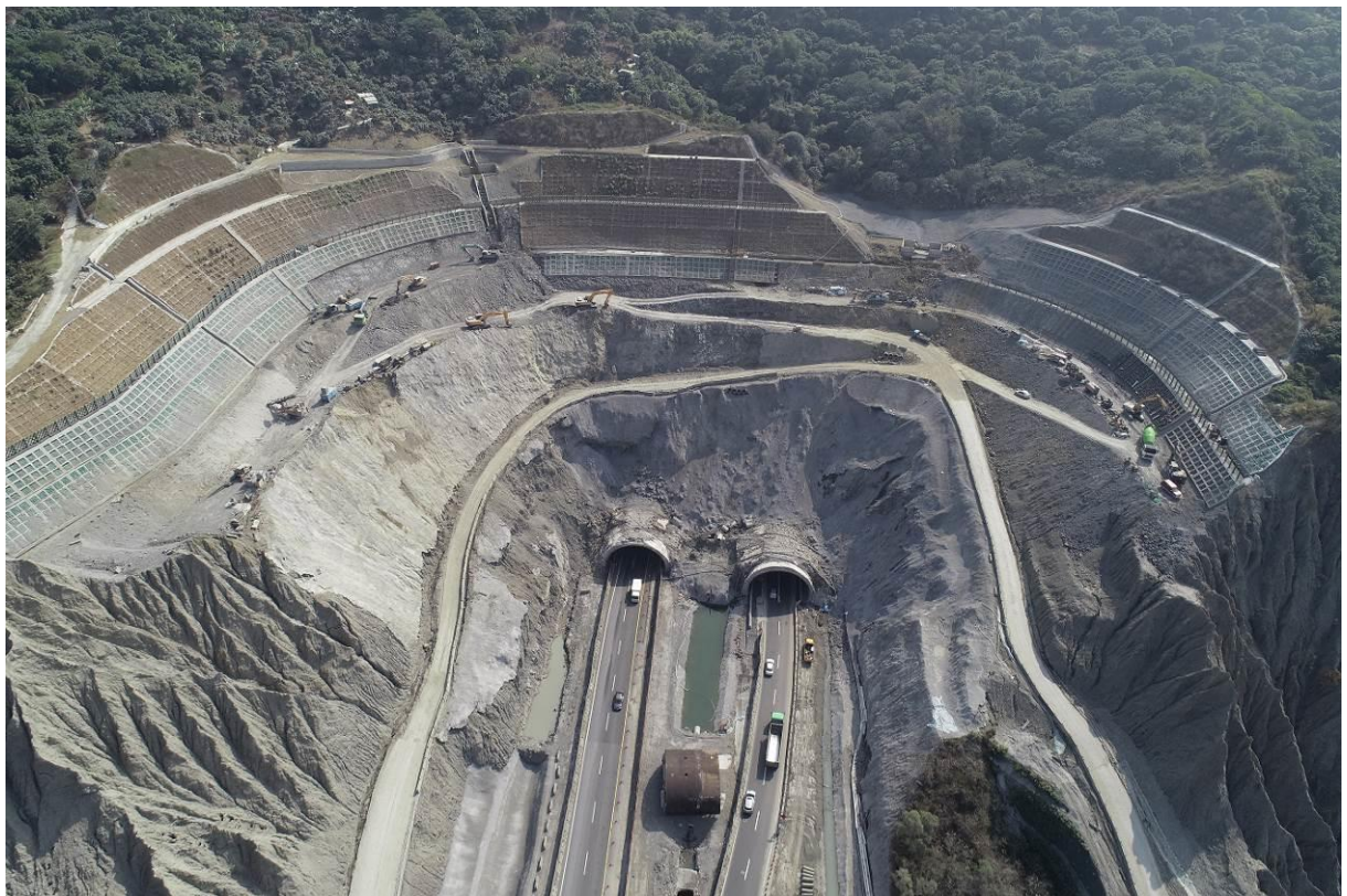
第 D11 標 中寮隧道路塹施工空拍圖
