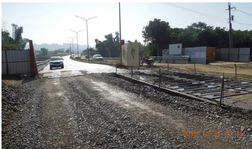
第L111及第L112合併標 工區出入口便道及洗車台
