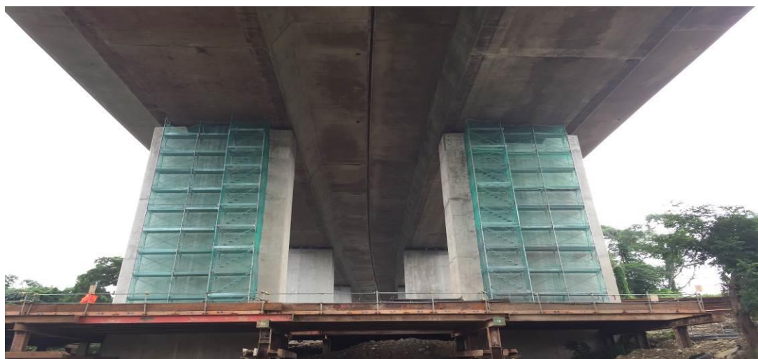
第M37A標 石龜溪河川橋P8鋼止震施工
