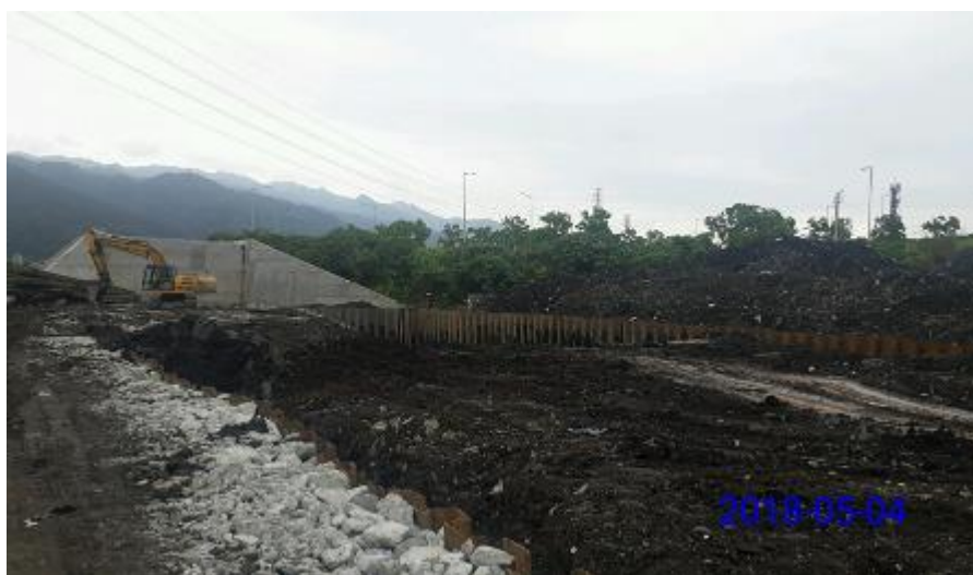
第 E14 標 匝道 R1 1+427~1+520 不適用材料挖除及卵塊石全置換
