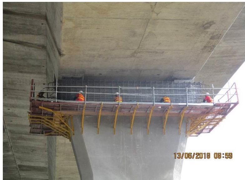
第 M37B 標 牛稠溪橋混凝土止震塊鋼筋綁紮
