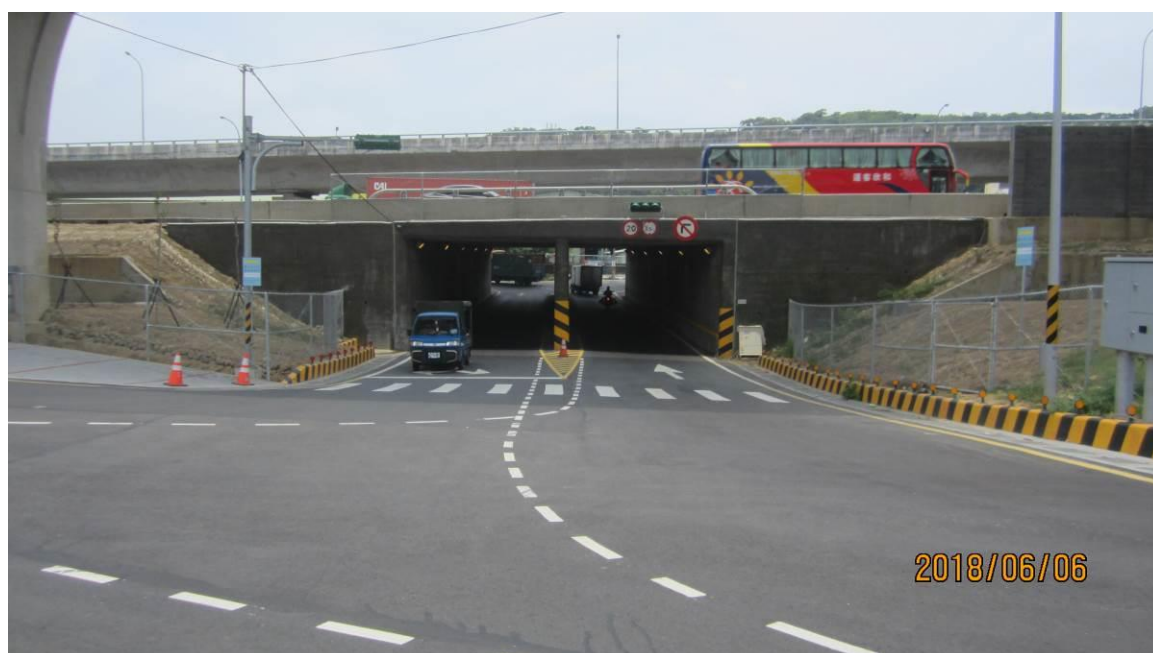
桃6線箱涵 通車後現況
