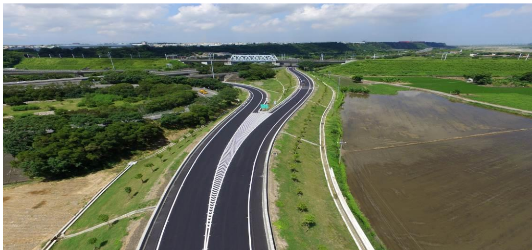
第 I14 標 北側匝道 R2 及 R5 竣工
