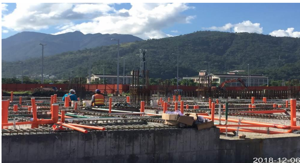
第 E252 標 東側廁所水電管線施工
