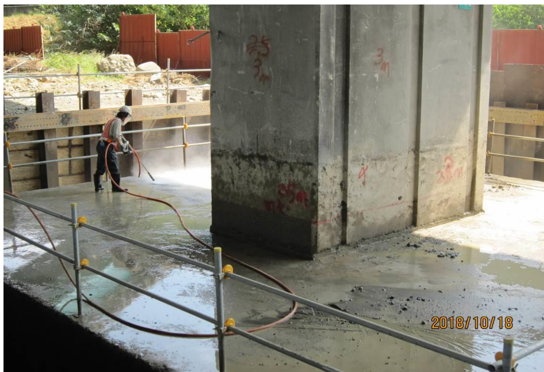
第 M41 標 P46R 基礎表面水刀處理施工
