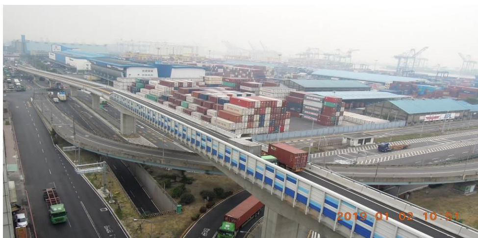
第CM01標 通車後高雄港聯外高架道路及四、五貨櫃中心遠景
