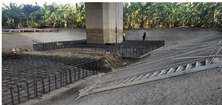
第M37D標 南投高架橋P83L基礎鋼筋綁紮
