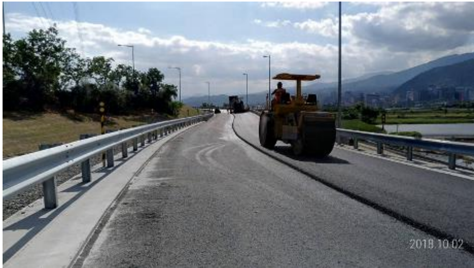
第 E14 標 匝道 R1 路堤段密級配瀝青混凝土鋪築
