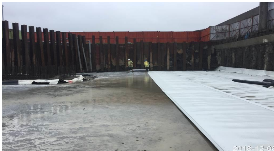
第 E252 標 地下一層基礎防水膜鋪設
