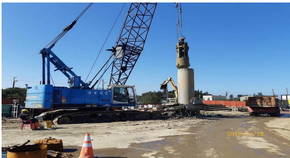
第 H72 標 T15RP4#1 全套管基樁鑽掘施工
