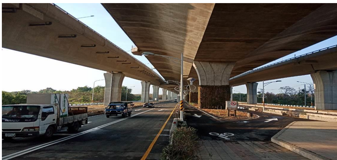
第D44標 交流道橋下道路通車情況
