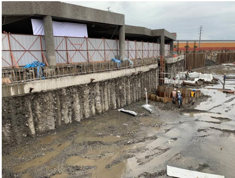
第 E252 標 預壘樁施作完成
