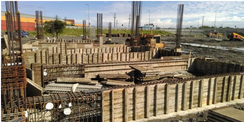
第 E252 標 東側廁所地梁鋼筋模板組立
