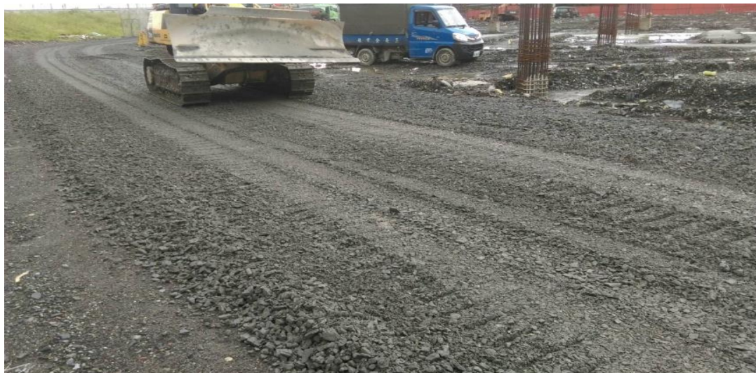
第 E252 標 環場道路路基碎石級配底層鋪設
