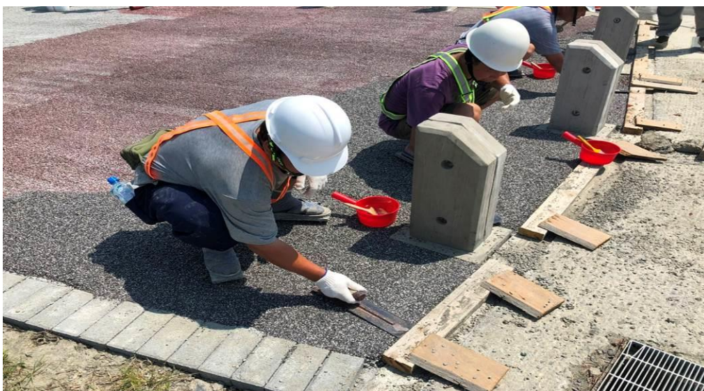
第 E251 標 停車場透水鋪面磁質面層施工
