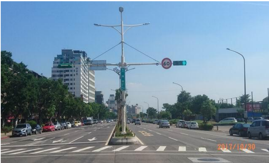
圖 2 忠孝東路 4 段與忠孝東路 4 段 553 巷—共桿安裝後
