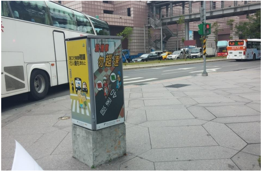
圖 5 信義路市府路口縮小型控制器(施工前)
