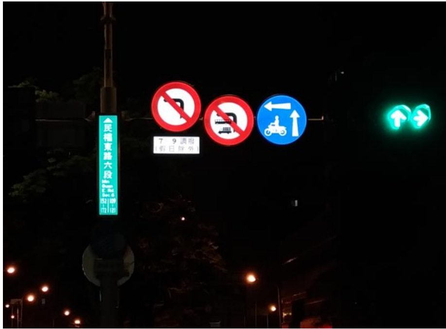
圖 17 民權東路 6 段內照式標誌
