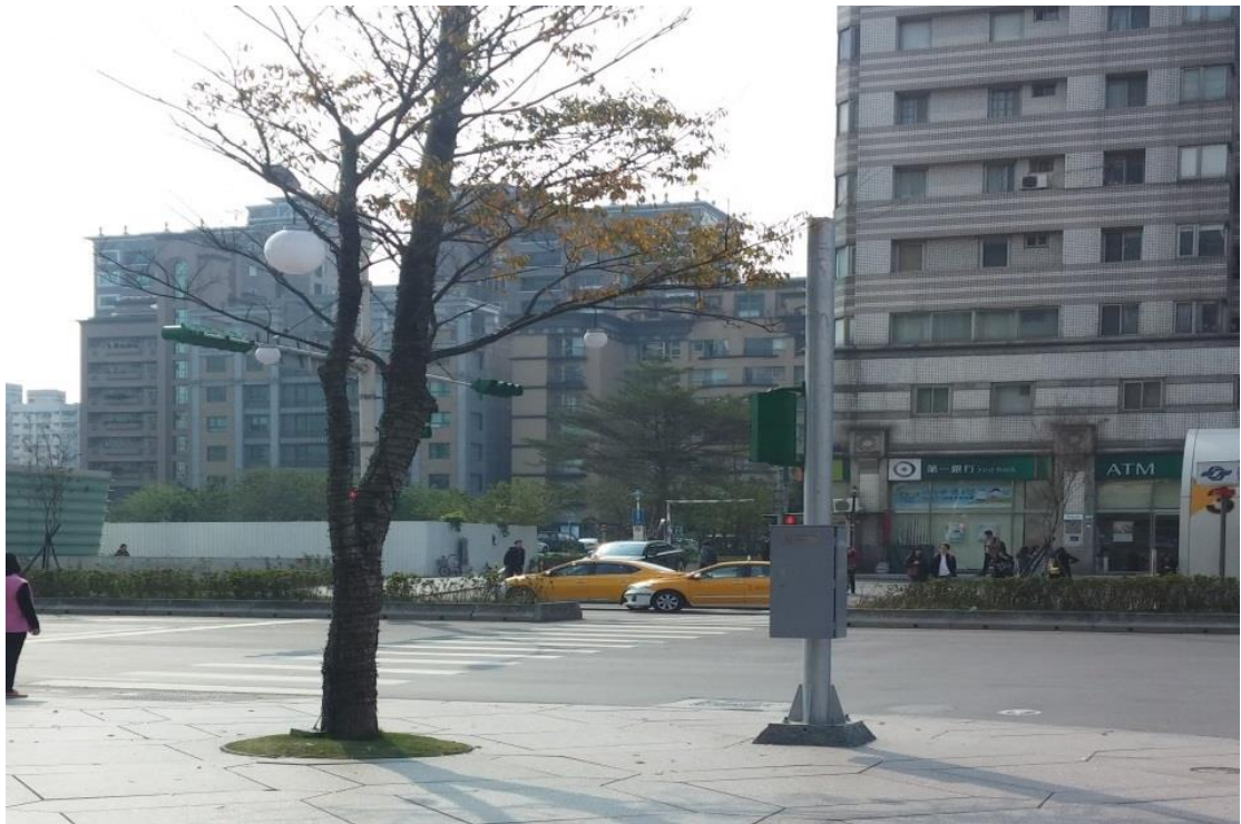
圖 6 信義路市府路口縮小型控制器(施工後)
