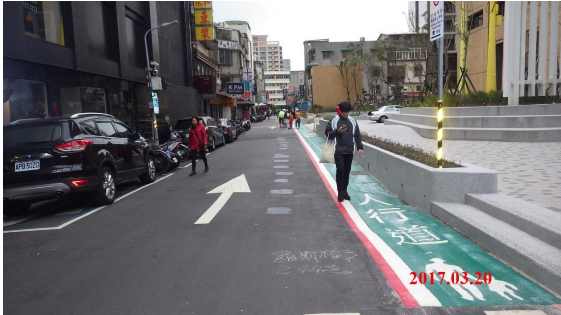
圖 8 忠孝東路 4 段 77 巷標線型人行道
