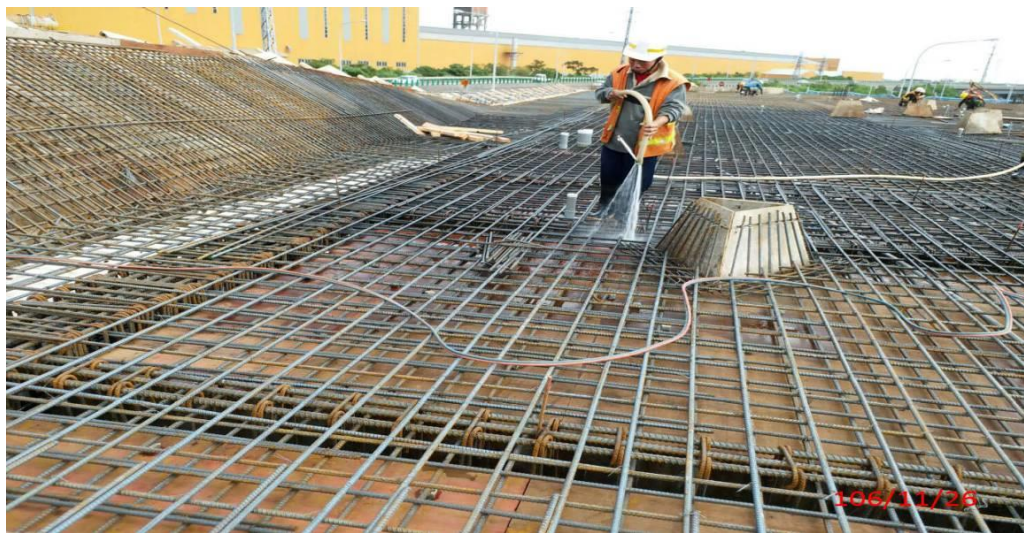
第 E251 標 西側廁所屋頂版混凝土澆置前清洗作業
