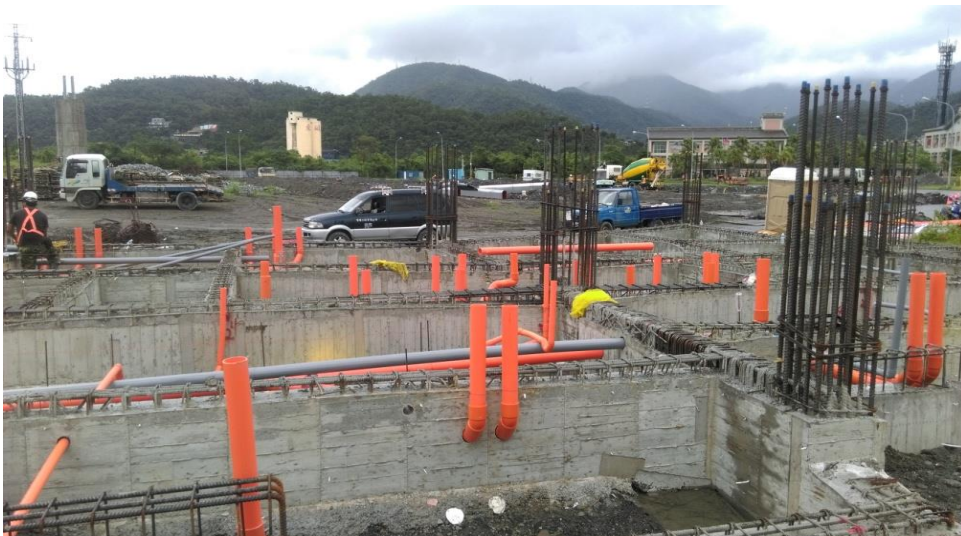
第 E251 標 西側廁所地梁排水管安裝
