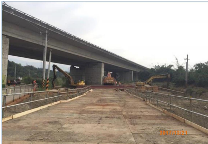
第 M37A 標 崙子溪河川橋便橋打設及 P5 圍堰
