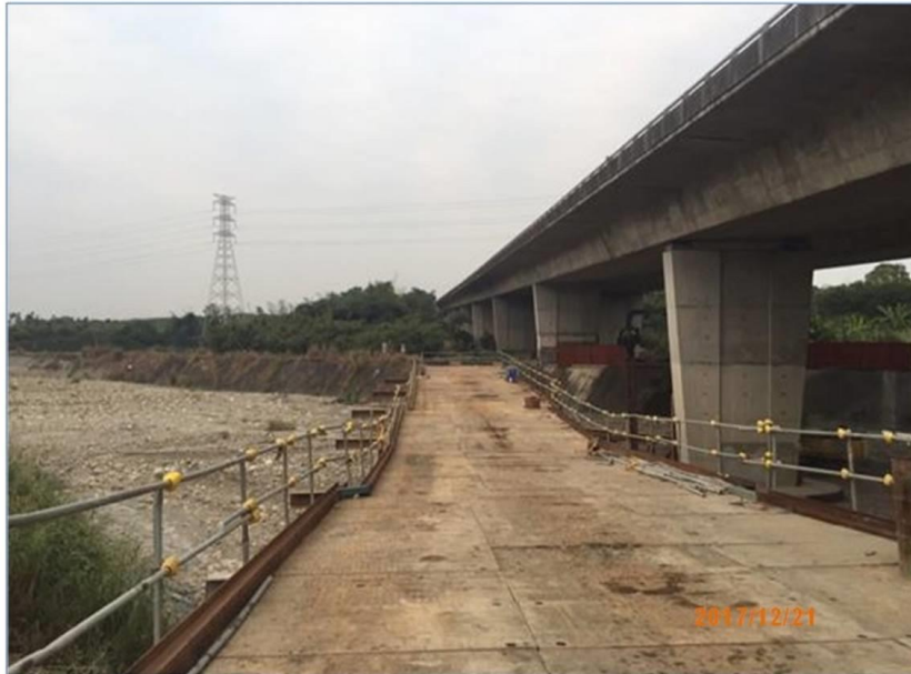
第 M37A 標 石牛溪河川橋便橋打設
