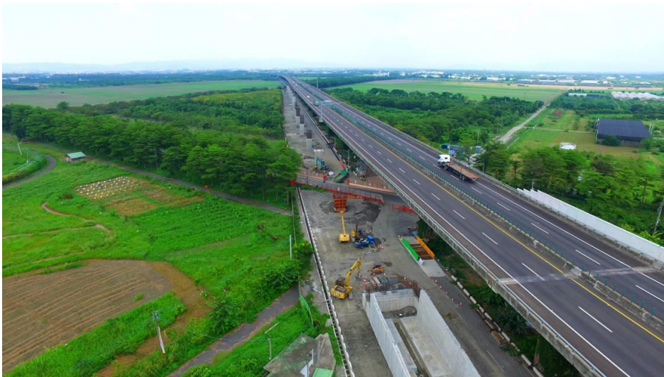
第D44標 鹽埔交流道南下側施工情形鳥瞰圖
