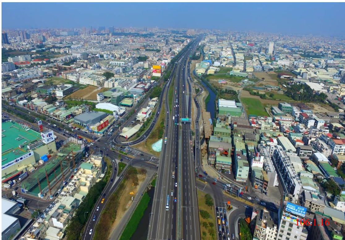
第591標 新設北出匝道完成後現況
