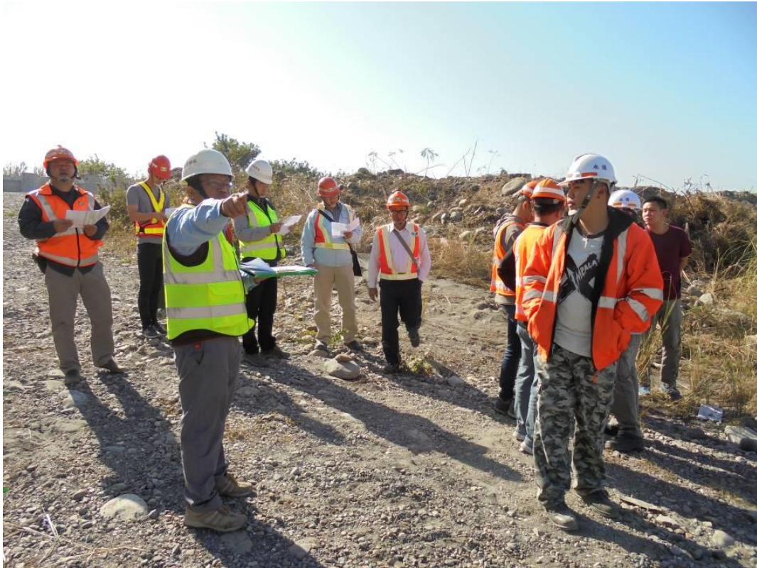
第 M37C1 標 濁水溪施工前會勘
