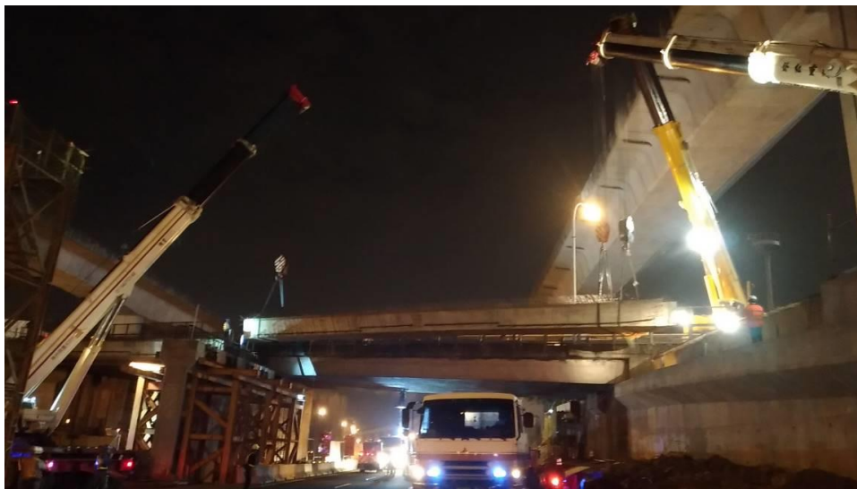
第 214 標 106 年 11 月 15 日夜間吊梁作業
