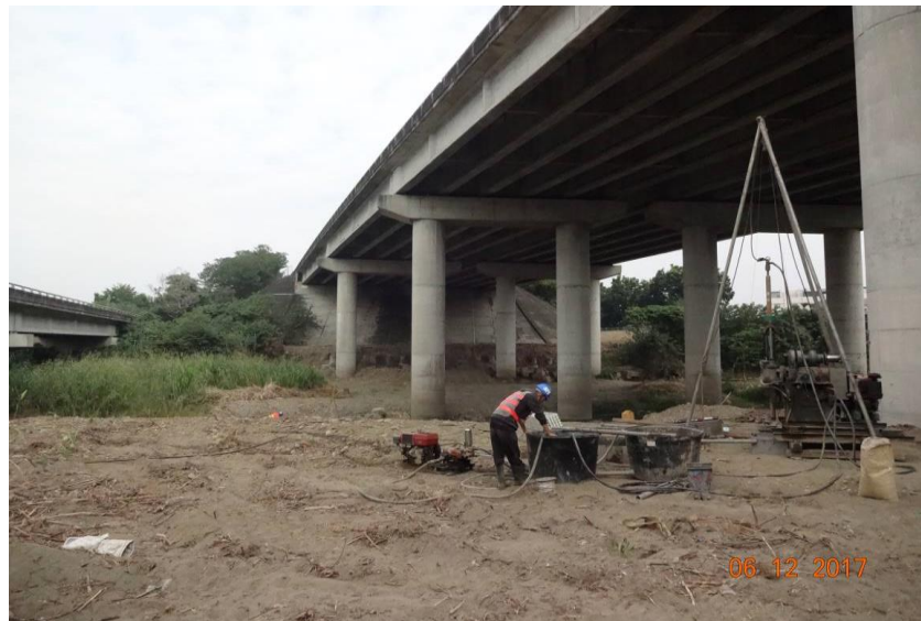
第 M37B 標 獅子頭溪河川橋補充地質鑽探
