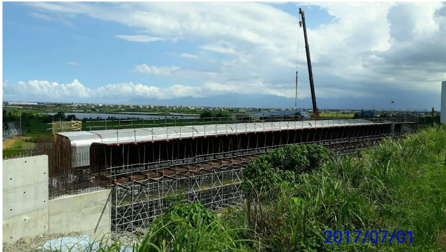
第 E14 標 L1 穿越橋箱型梁腹版模吊裝
