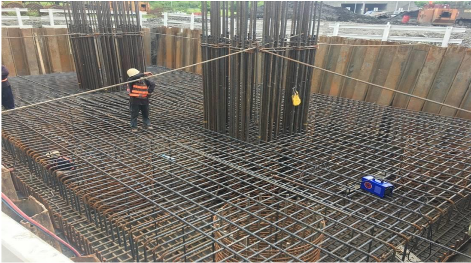
第 E251 標 P1 基礎及墩柱鋼筋綁紮組立
