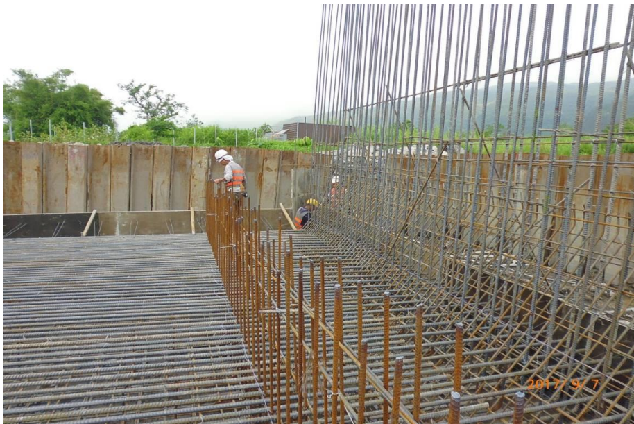
第 E14 標 R1 匝道穿越箱涵底板鋼筋綁紮
