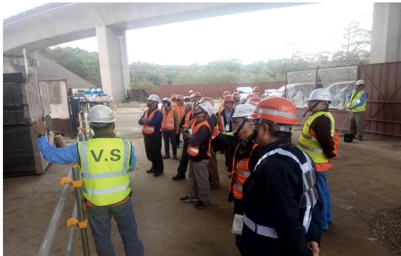
第 I14 標 交通部施工查核情形
