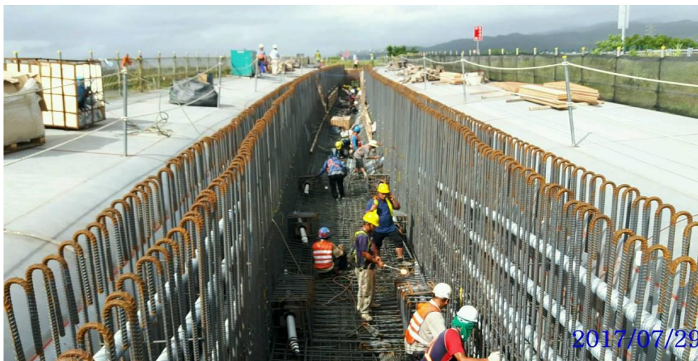
第 E14 標 L1 穿越橋箱型梁腹板鋼筋綁紮
