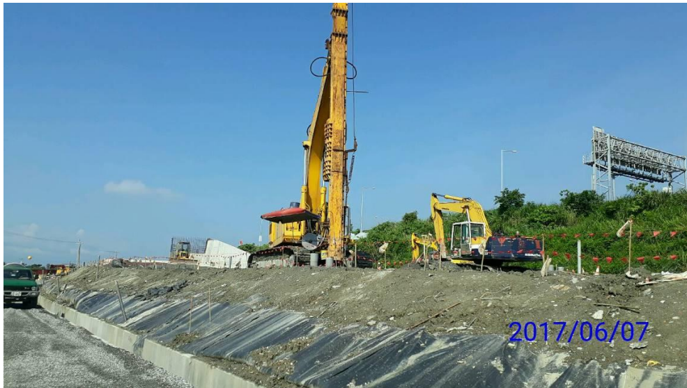
第 E14 標 L1 匝道排水帶工法打設排水帶
