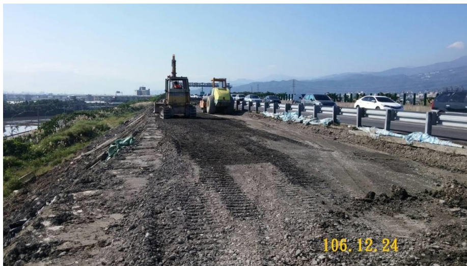
第 E14 標 L1 匝道第 1 區路堤填築
