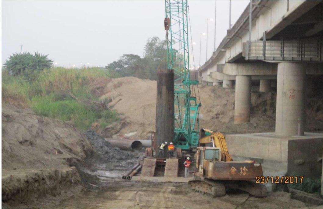
第 M37B 標 龜重溪河川橋 TP4 試驗樁施工
