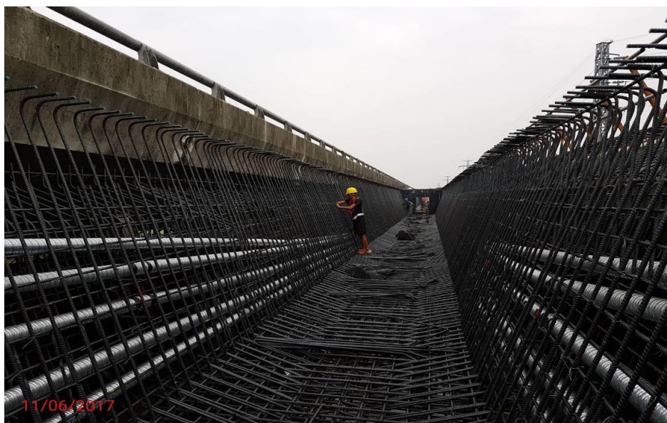
第D44標 鹽埔交流道北入匝道PN1~PN3 箱型梁牆身及翼版鋼筋綁紮作業
