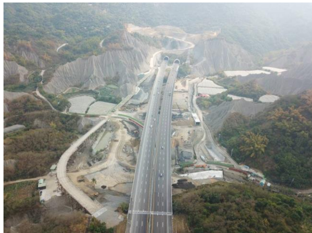
第 D11 標 中寮隧道改善工程施工空拍圖
