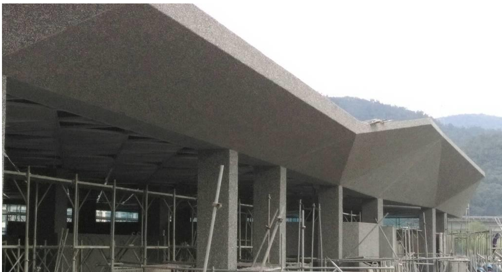
第 E251 標 西側廁所北側折板洗石子
