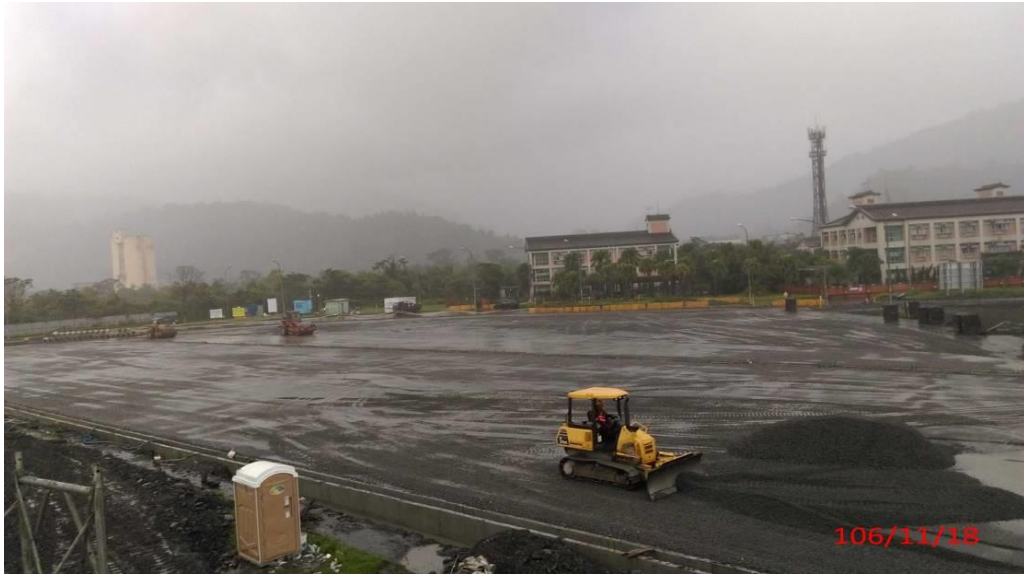
第 E251 標大型停車場剛性路面級配回填
