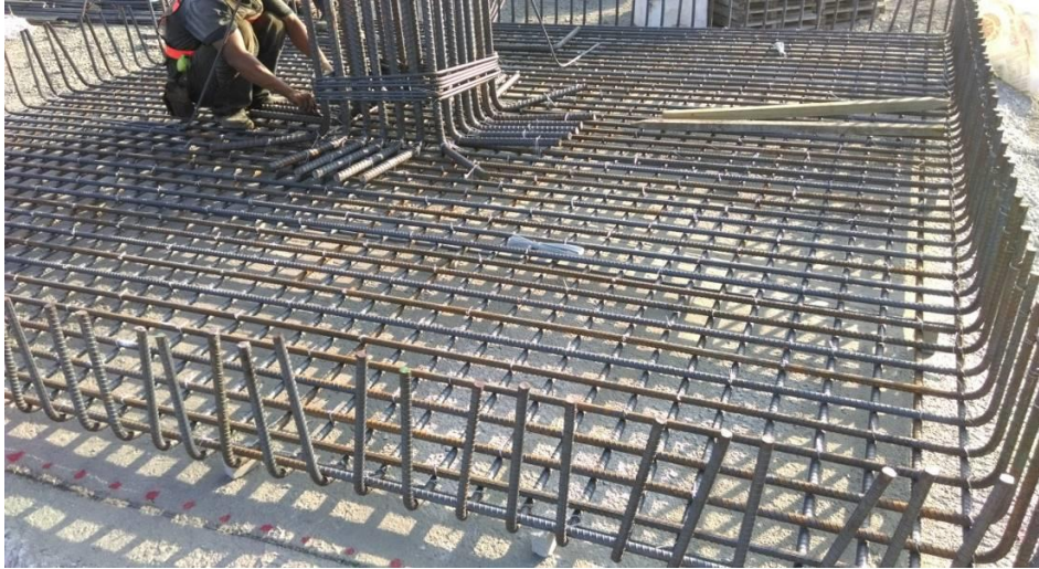
第 E251 標 西側廁所基礎鋼筋綁紮組立
