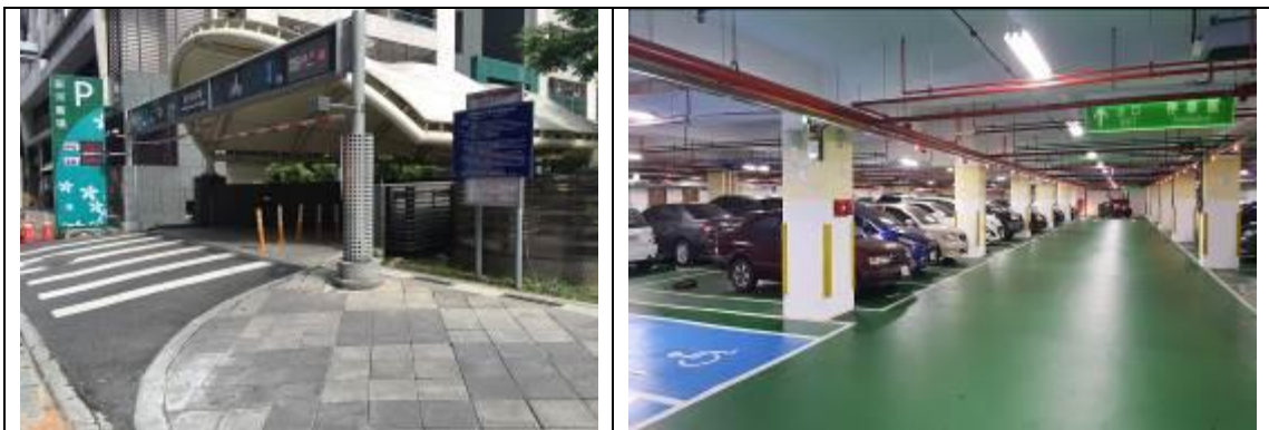
圖 5 中壢區銀河廣場地下停車場（活化）
