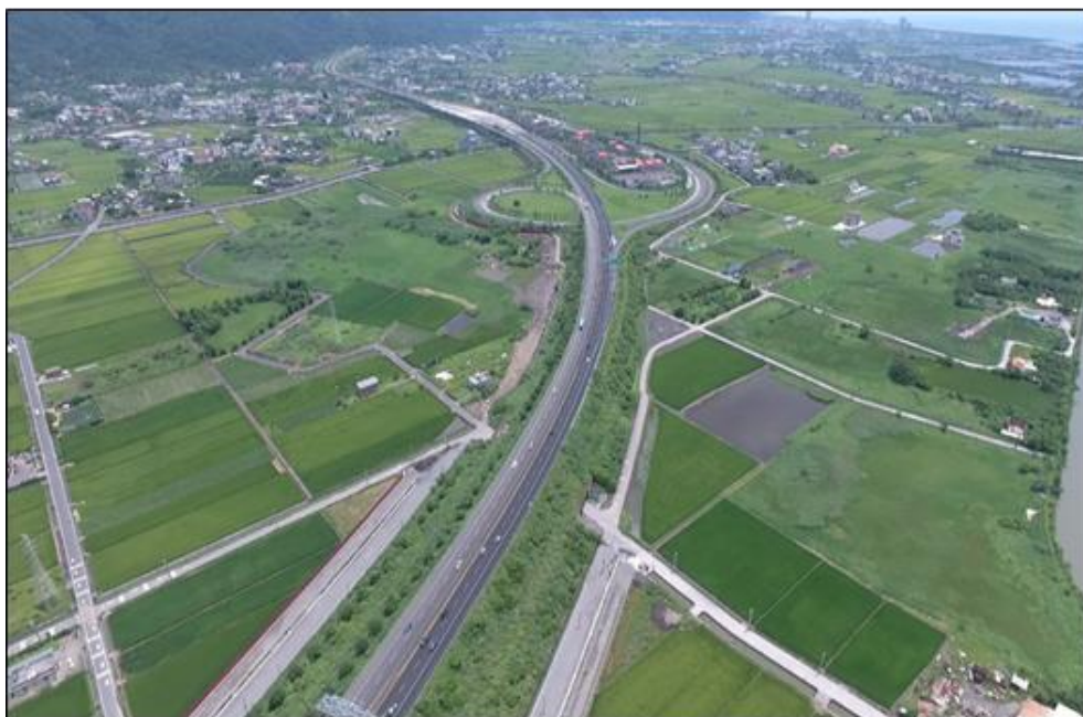
第 E14 標 國 5 頭城交流道增上下匝道空拍圖
