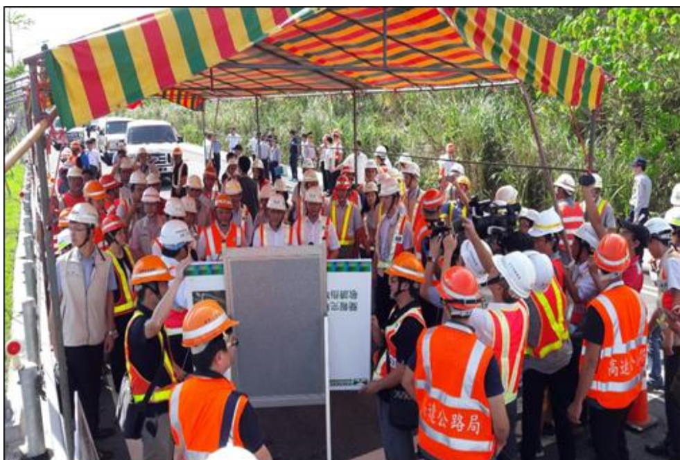
第 E14 標 院長視察國 5 頭城交流道增上下匝道工程
