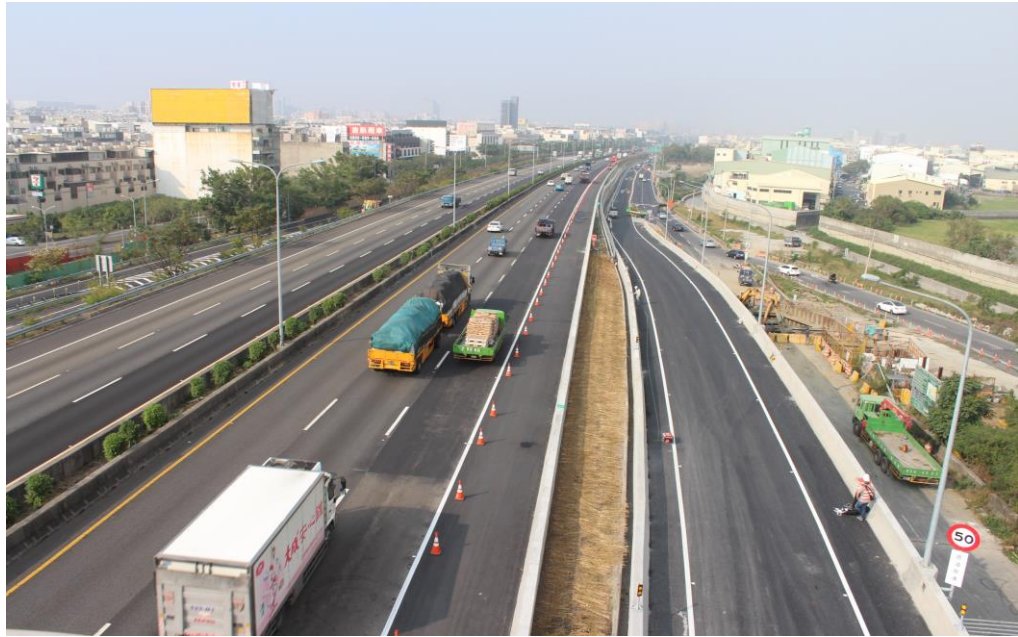
第 591 標 新設北上出匝道完成後現況
