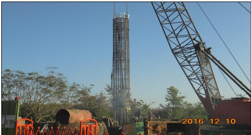
第 D44 標 國 3 鹽埔交流道基樁施工
