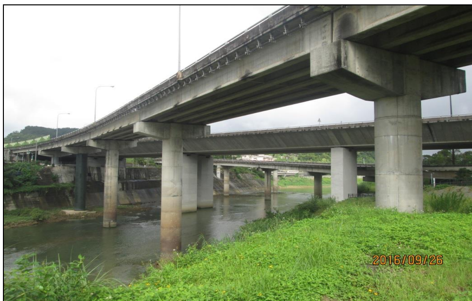
第 M31 標 國 3 汐止系統交流道跨北側基隆河橋補強完成
