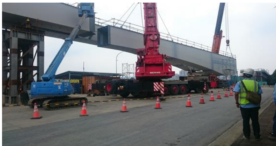
第 B34 標 國道 3 號增設樹林交流道南向出口匝道鋼箱梁吊裝
