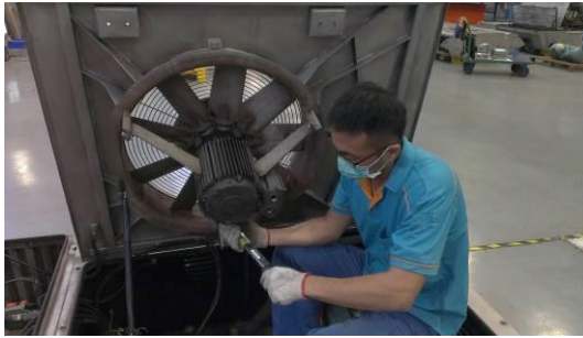
冷凝風扇檢修
