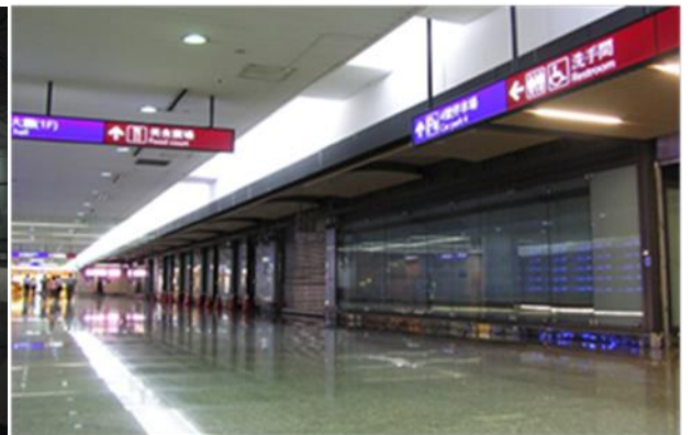
機場捷運第二航廈站(A13)穿堂層
