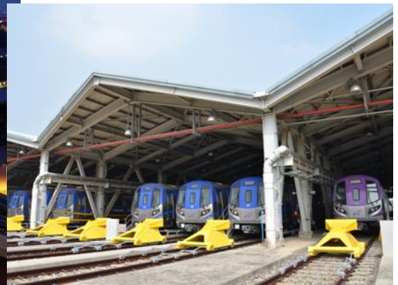
青埔機廠電聯車駐車場
