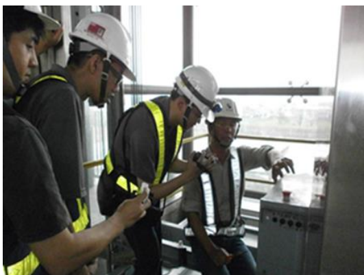
電梯/電扶梯執行教育訓練
