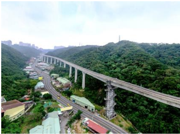
青山路段高架橋
