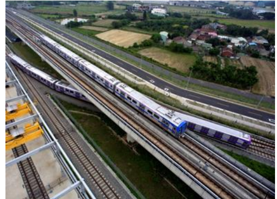
青埔機廠電連車主線與進出廠線
