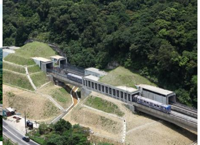
青山路段明挖覆蓋隧道
