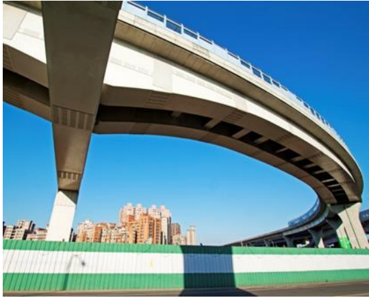
二重疏洪道路段高架橋
