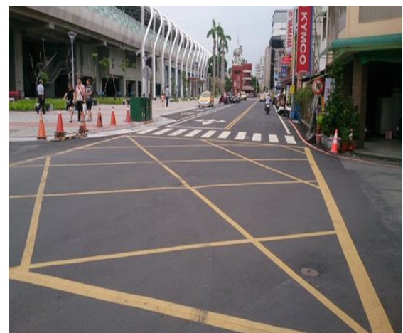
員林車站東側光復街復舊標線劃設
