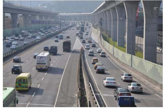
國道 1 號五股交流道南下入口匝道 施工後
