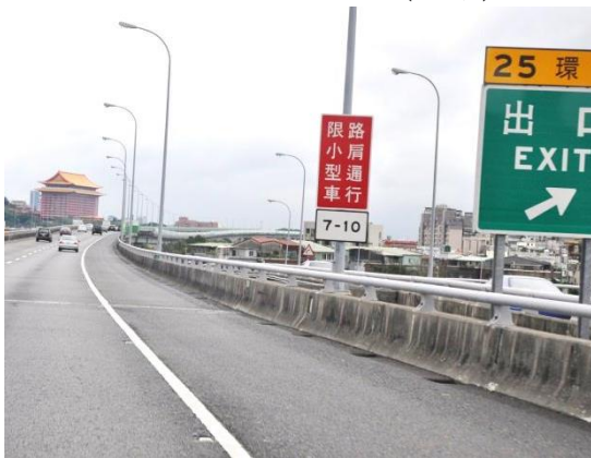
國道 1 號高架道路環北-下塔悠(北上)
