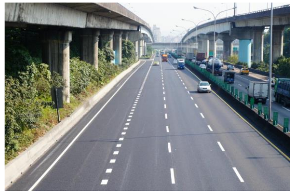
國道 1 號南下汐止交流道至東湖交流道 施工後
