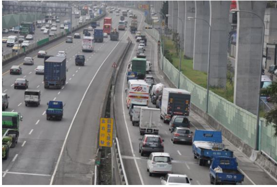
國道 1 號五股交流道南下入口匝道 施工前
