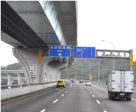
國道 1 號五楊高架南下泰山轉接道至機場系統上坡路段高乘載車道入口
