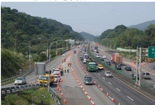
南港系統交流道交維布設情形
