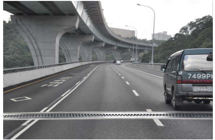
國道 1 號五楊高架南下泰山轉接道至機場系統上坡路段增加匯出區間
