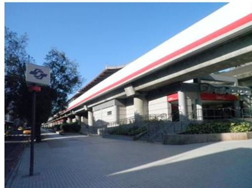
圖 10 臺北捷運高運量隔音牆
