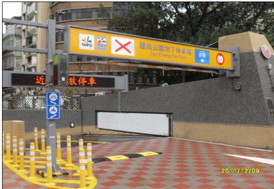
圖 1 建成公園地下停車場
