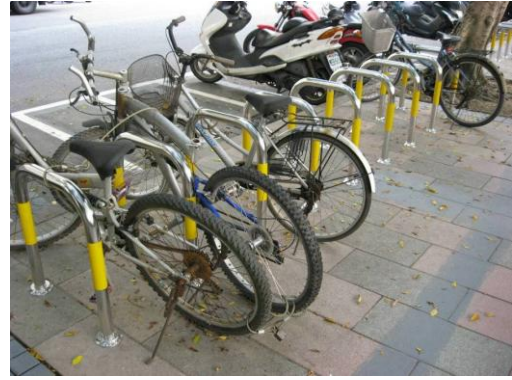
圖 9 U桿型自行車架 (鎖車身，適用於人行道設施帶較窄地點)
