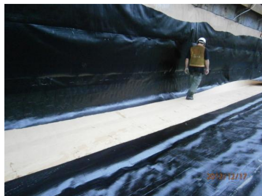
基隆車站底版防水膜施作
