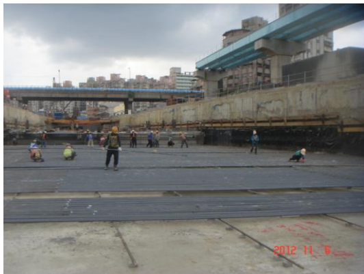
基隆車站第 2 區塊底版鋼筋組立施作
