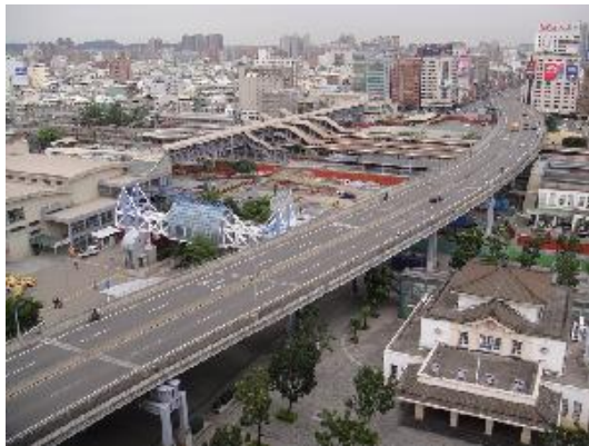
高雄車站臨時軌及擋土壁工程施工情形
