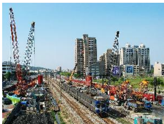
青海路及九如路段鐵路地下化工程施工情形
