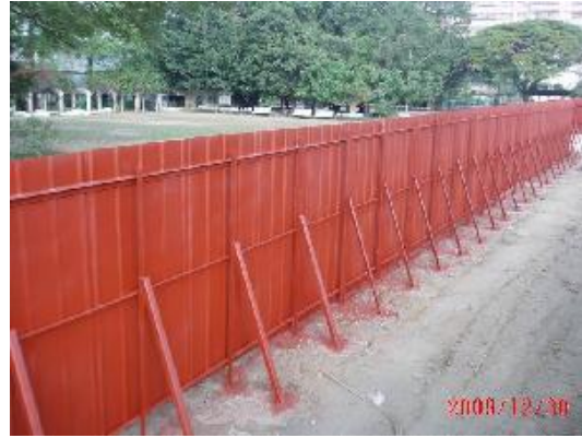
大順路段鐵路地下化工程施工情形
