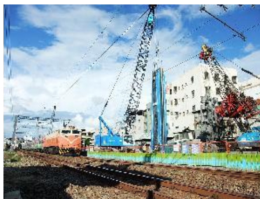
中華三段鐵路地下化工程施工情形
