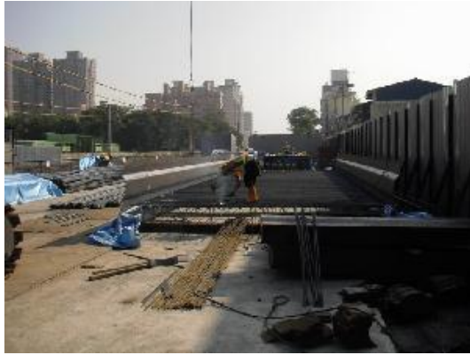
民族路段鐵路地下化工程施工情形
