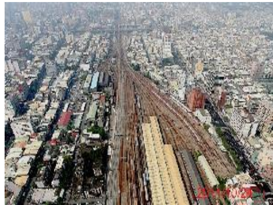
高雄車站地下化工程施工情形
