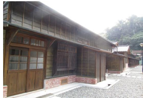
車埕鐵道文化宿舍整建工程
