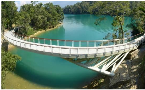
向山自行車道景觀跨橋工程
