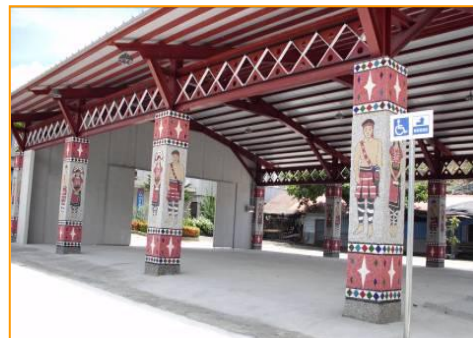
觀音鐵馬驛站景觀改善工程
