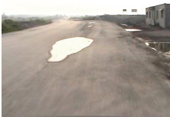
圖 5.35 鋪面破壞積水處
