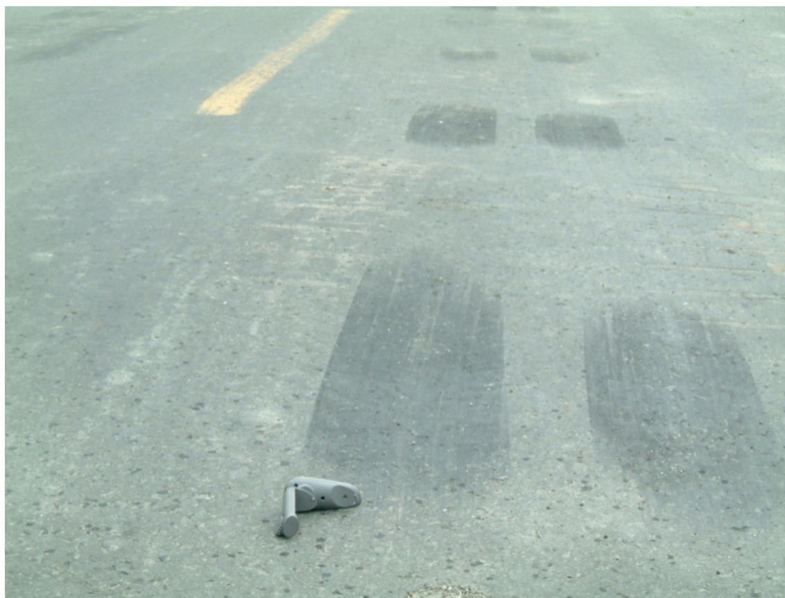
圖 5.30 轉爐石再利用瀝青混凝土鋪面凸起照-測線 A1
