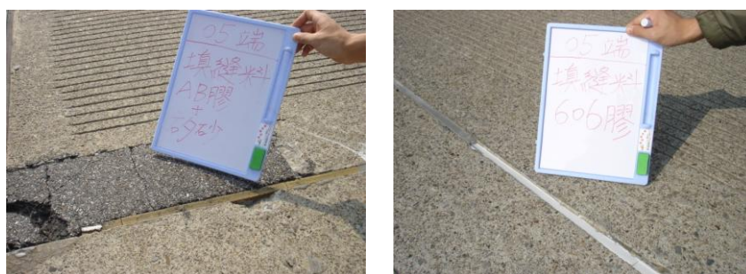
圖 3.2.6 填縫料：(左)AB 膠+矽砂(跑道 05 端)，(右)606 膠(跑道 05 端)
