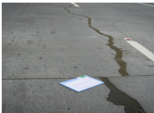
圖 3.2.18 二高南投名間段北上 232k+500 鋪面版裂縫修補後再破壞
