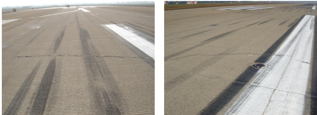
圖 3.2.1 (左)橫向裂縫(跑道 05 端)，(右)角隅裂縫(跑道 05 端)
