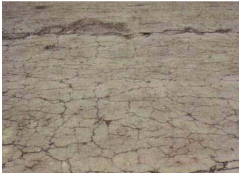
圖 3.1.8 圖狀裂縫
