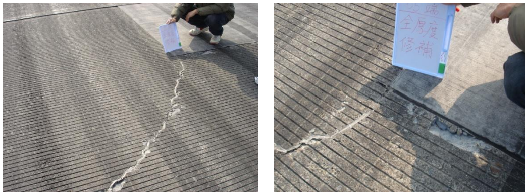
圖 3.2.9 全厚度修補後破壞情形
