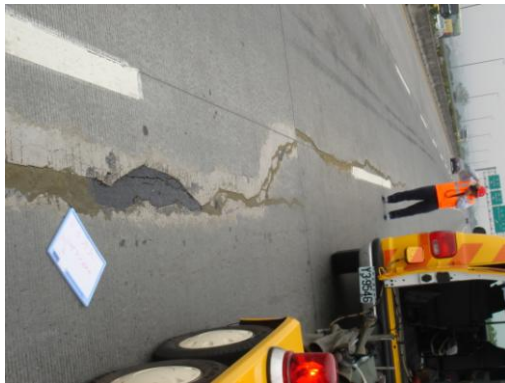
圖 3.2.23 北上 237+400 鋪面破壞後修補情形
