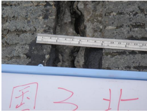
圖 3.2.22 北上裂縫破損情形
