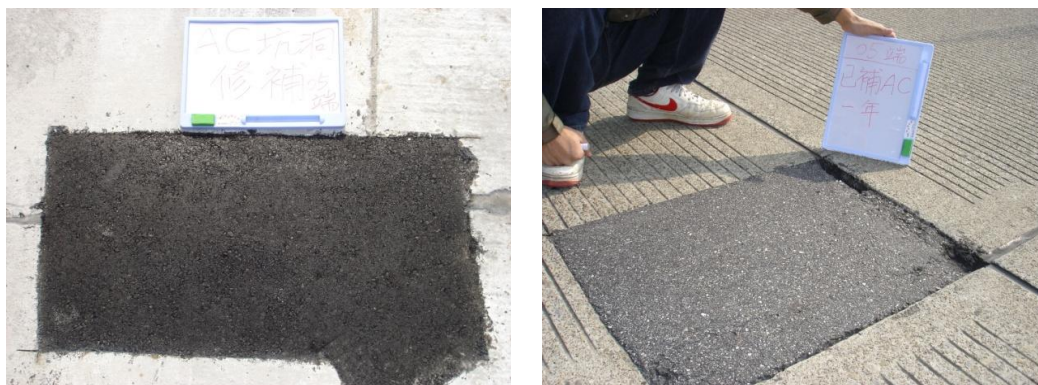
圖 3.2.4 AC 修補，(左)新鋪，(右)修補一年
