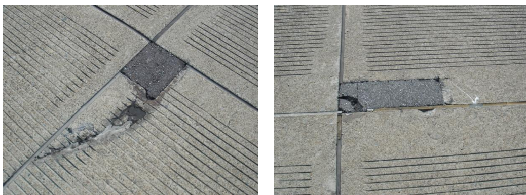
圖 3.2.5 AC 修補破壞
