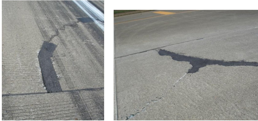
圖 3.2.11 裂縫 AC 修補
