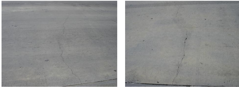
圖 3.2.29 北上外車道橫向裂縫
