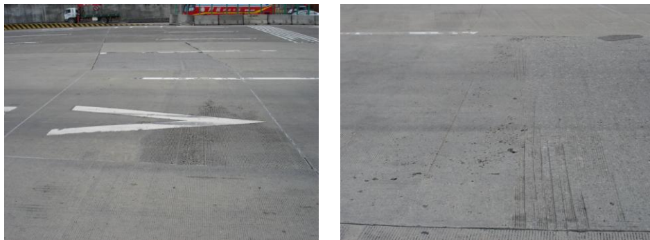
圖 3.2.30 南下車道路面風化侵蝕
