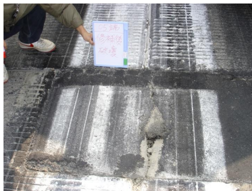
圖 3.2.2 修補後破壞(跑道 05 端)
