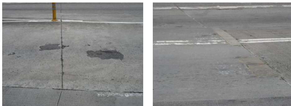
圖 3.2.34 (左)AC 暫時性修補 (右)矽砂材料做半永久式修補
