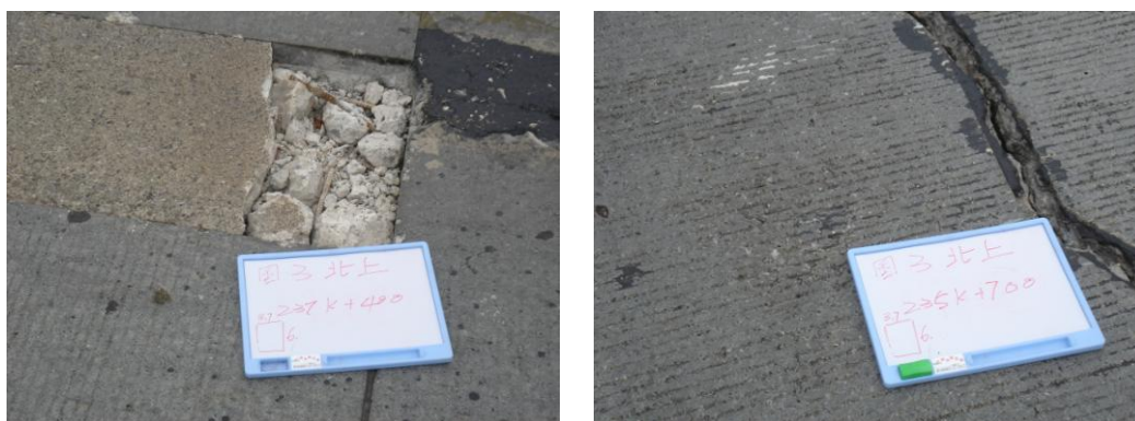
圖 3.2.17 二高南投名間段修補後再破壞之情形
