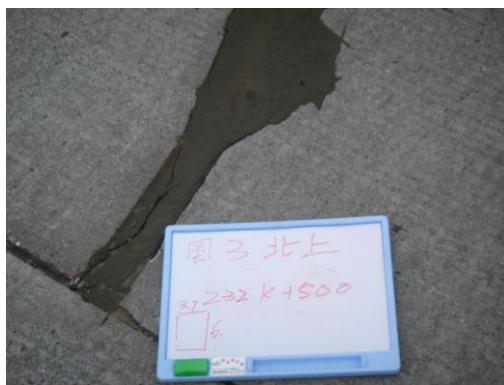
圖 3.2.19 二高南投名間段北上 232k+500 鋪面版修補後再破壞
