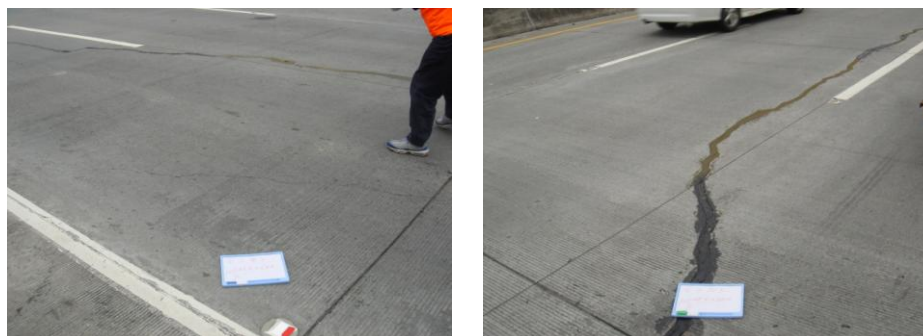
圖 3.2.16 二高南投名間段角隅裂縫破壞情形
