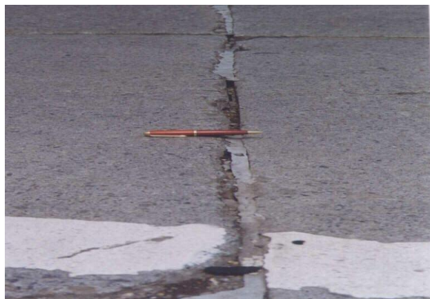
圖 3.1.6 接縫填縫料破壞
