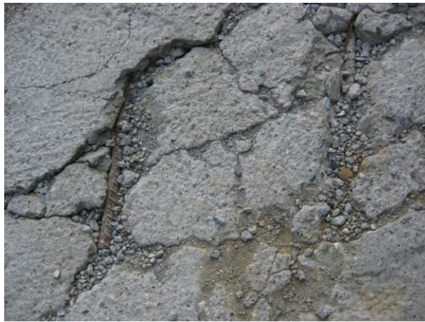
圖 3.2.46 鋼筋裸露情形
