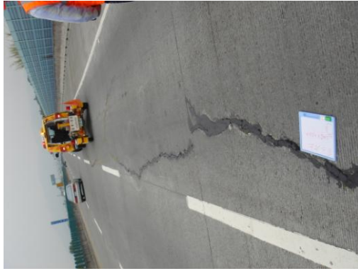
圖 3.2.21 二高南投名間段北上 235k+600 裂縫修補後再破壞
