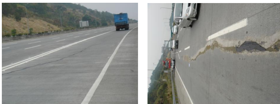
圖 3.2.15 二高南投名間段縱向裂縫破壞情形
