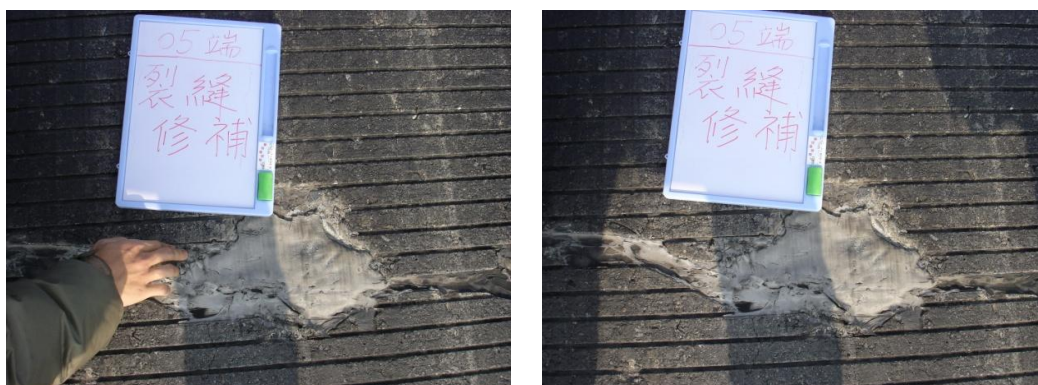
圖 3.2.14 裂縫修補不實
