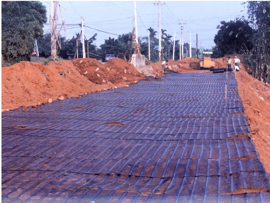
圖 4-10 加勁材料鋪設前定位避免鋪設誤差
