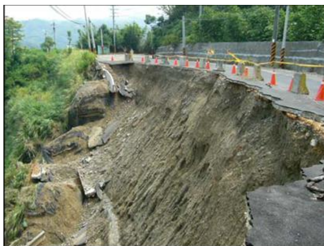
圖 2-12 加勁擋土結構全面坍滑破壞
