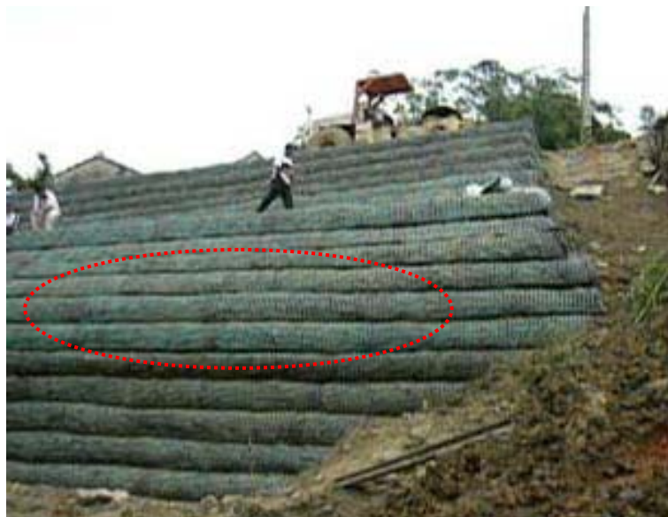
圖 2-5 加勁擋土牆牆面變形外鼓
