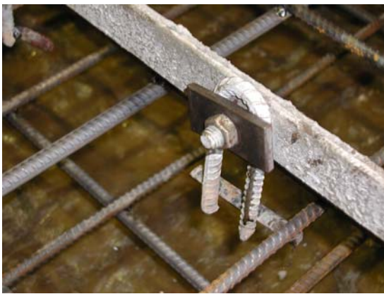
圖 7-11 面版連結構件施作示意圖
