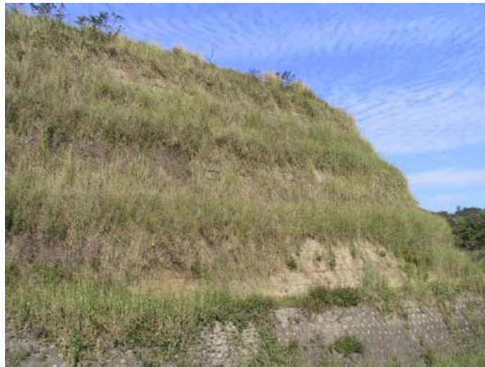
圖 2-13 加勁擋土結構表面土壤流失
