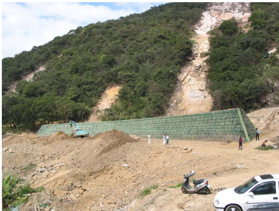
圖 3-8 加勁擋土結構土石圍堵屏障完工情況
