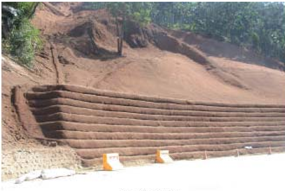
圖 3-16(a) 邊坡整治坡面植生初期現況
