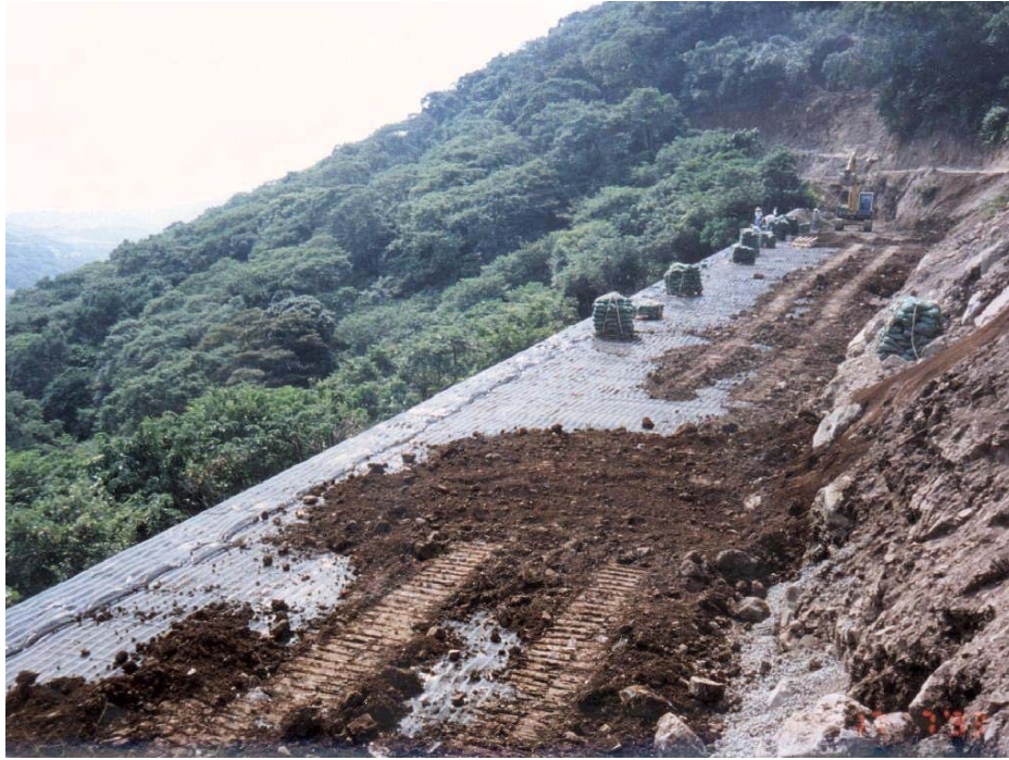
圖 4-12 加勁材料鋪設後工程車輛行經加勁區須進行保護
