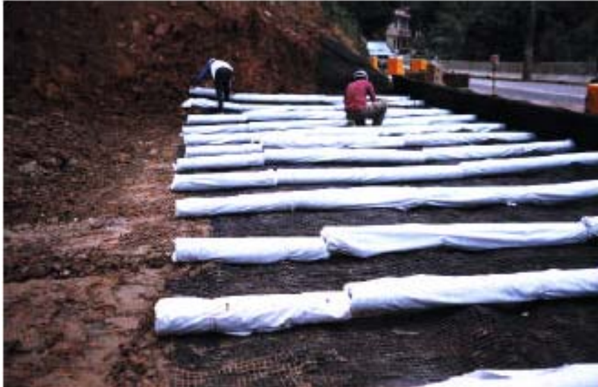
圖 3-14(a)圓型排水設施施工圖
