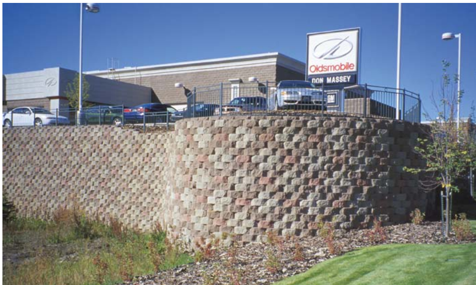
圖 3-2 預鑄式剛性面版結合都市景觀設計示意圖
