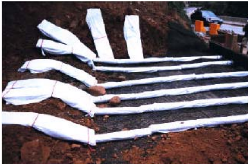
圖 3-14(b)扁型排水設施施工圖
