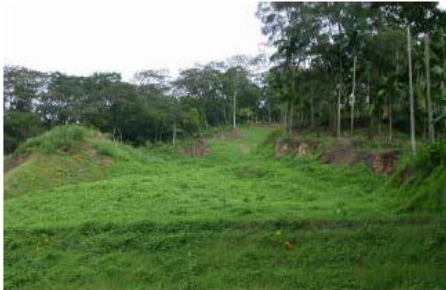
圖 3-16 (b) 邊坡整治坡面植生完成記錄
