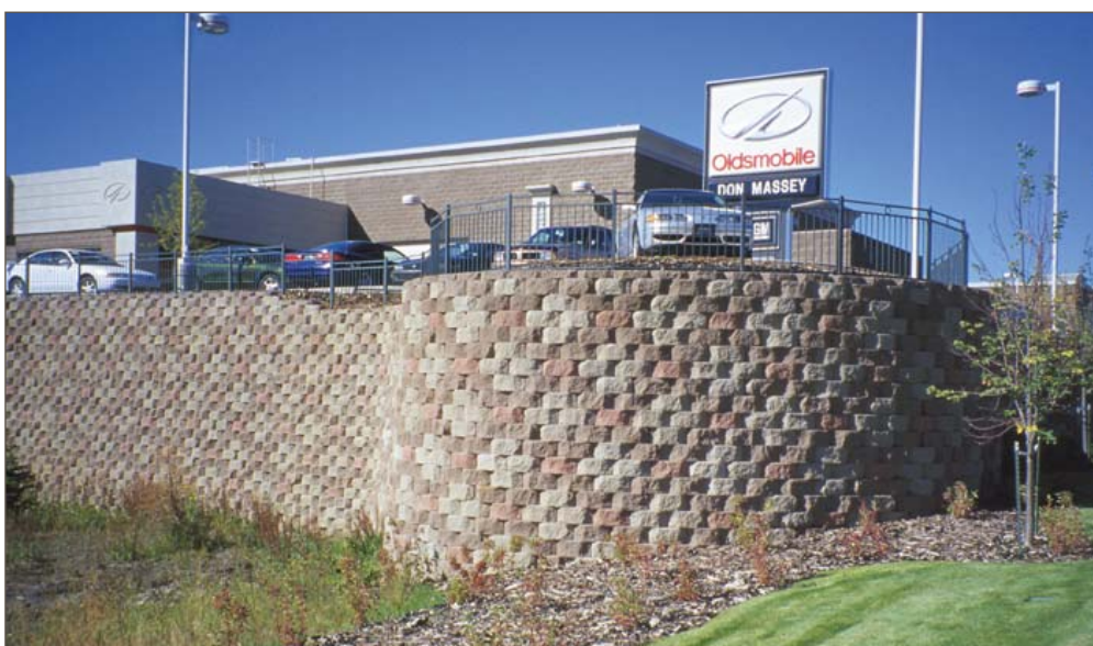
圖 2-18 堆疊式預鑄混凝土面版
