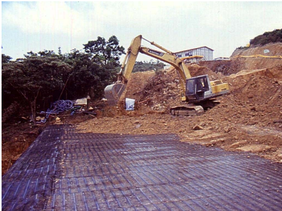
圖 4-14 填築土料鋪設施工機具施作示意圖
