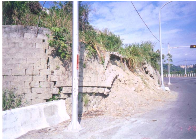
圖 5-9 集集地震時大坑地區加勁進擋土牆破壞案例
