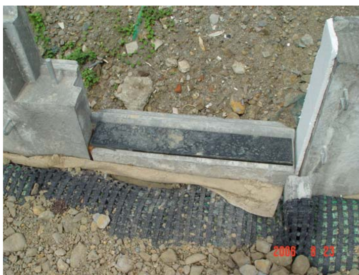
圖 7-13 面版水平接縫緩衝材料示意圖
