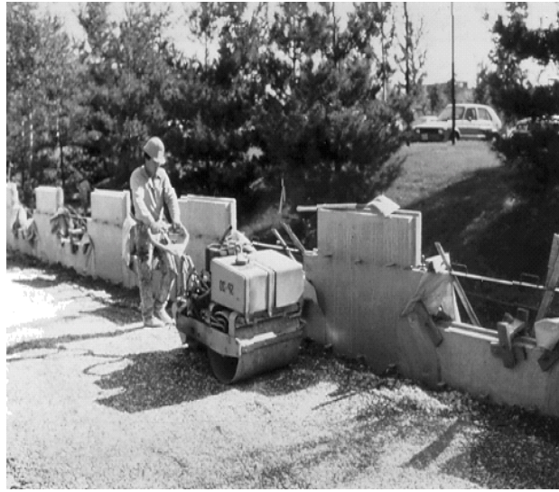
圖 7-9 近牆面區填築土料夯實示意圖
