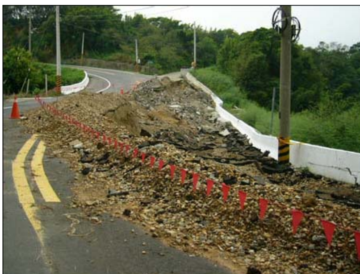
圖 2-7 加勁擋土牆牆頂沉陷開裂
