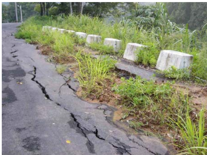
圖 2-6 加勁擋土牆牆頂外傾
