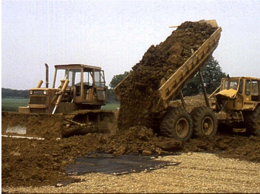
圖 4-13 填築土料鋪設施工機具施作示意圖
