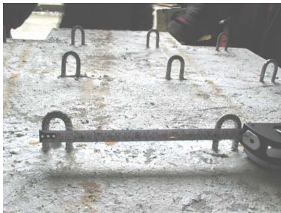
圖 7-11 面版連結構件施作示意圖
