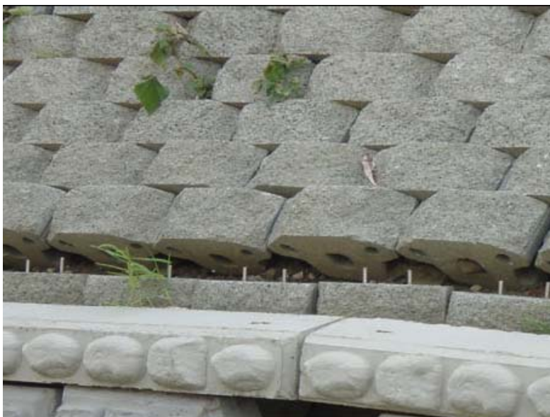
圖 2-8 加勁擋土牆與加勁材料連接點破壞
