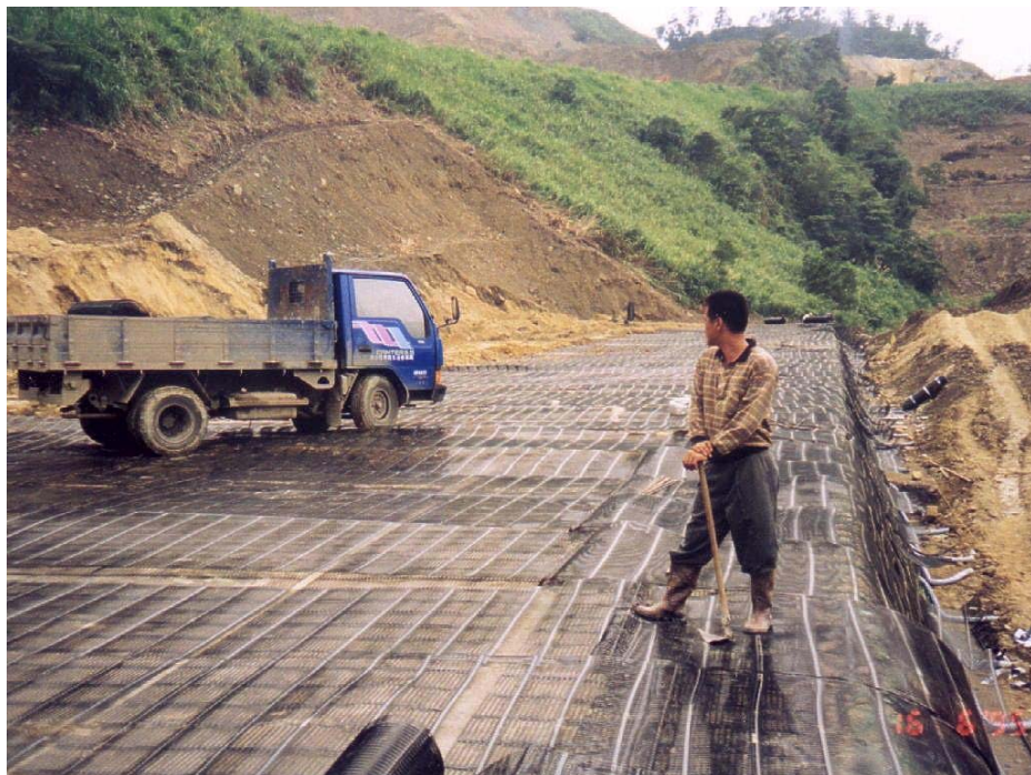
圖 4-11 加勁材料鋪設後禁止工程車輛直接滾壓
