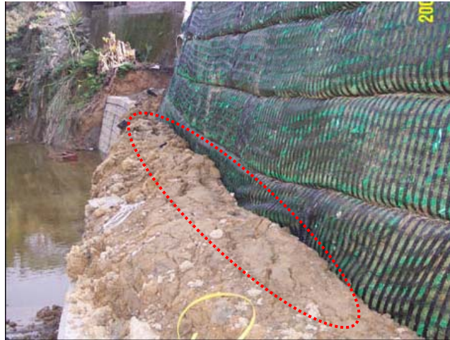
圖 2-11 加勁擋土結構基礎承載破壞
