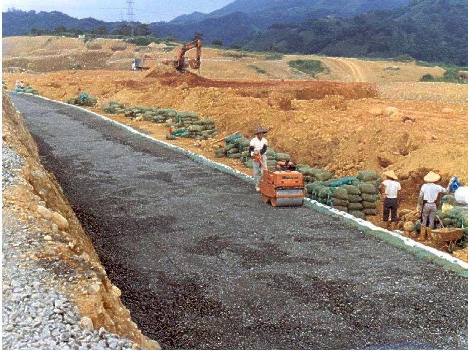
圖 4-15 填築土料鋪設小型施工機具施作示意圖
