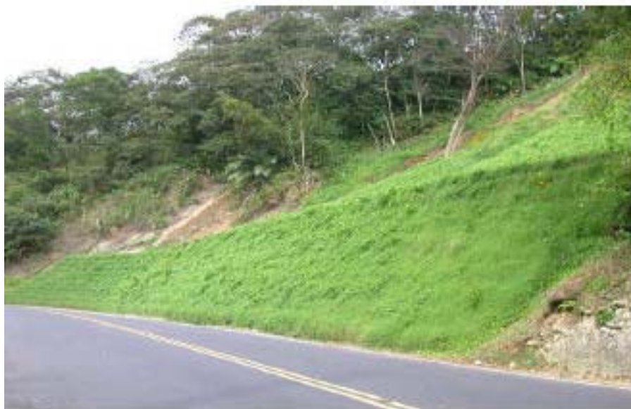
圖 3-16(c) 邊坡整治坡面植生完成記錄
