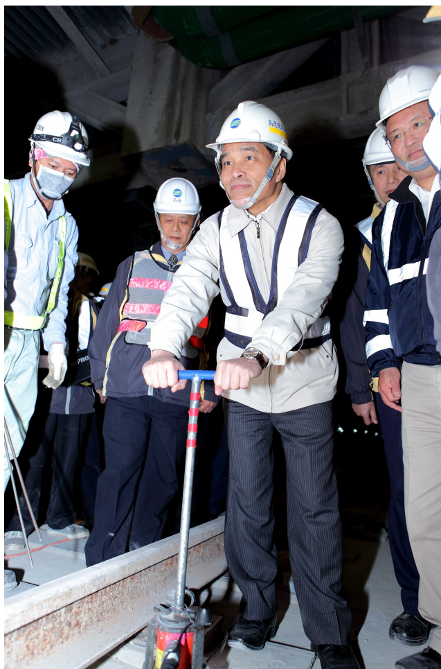
圖 2 部長親身操作機場捷運台北車站(A1)道床之頂升設備
