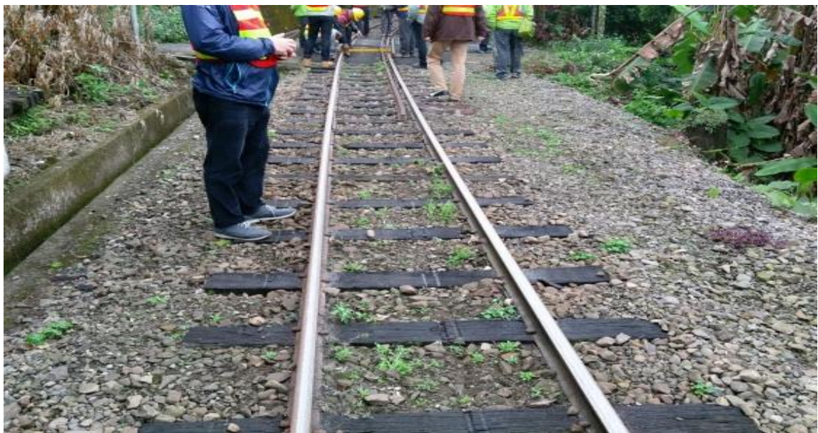
圖 3.4-2 列車出軌輪軌壓痕
