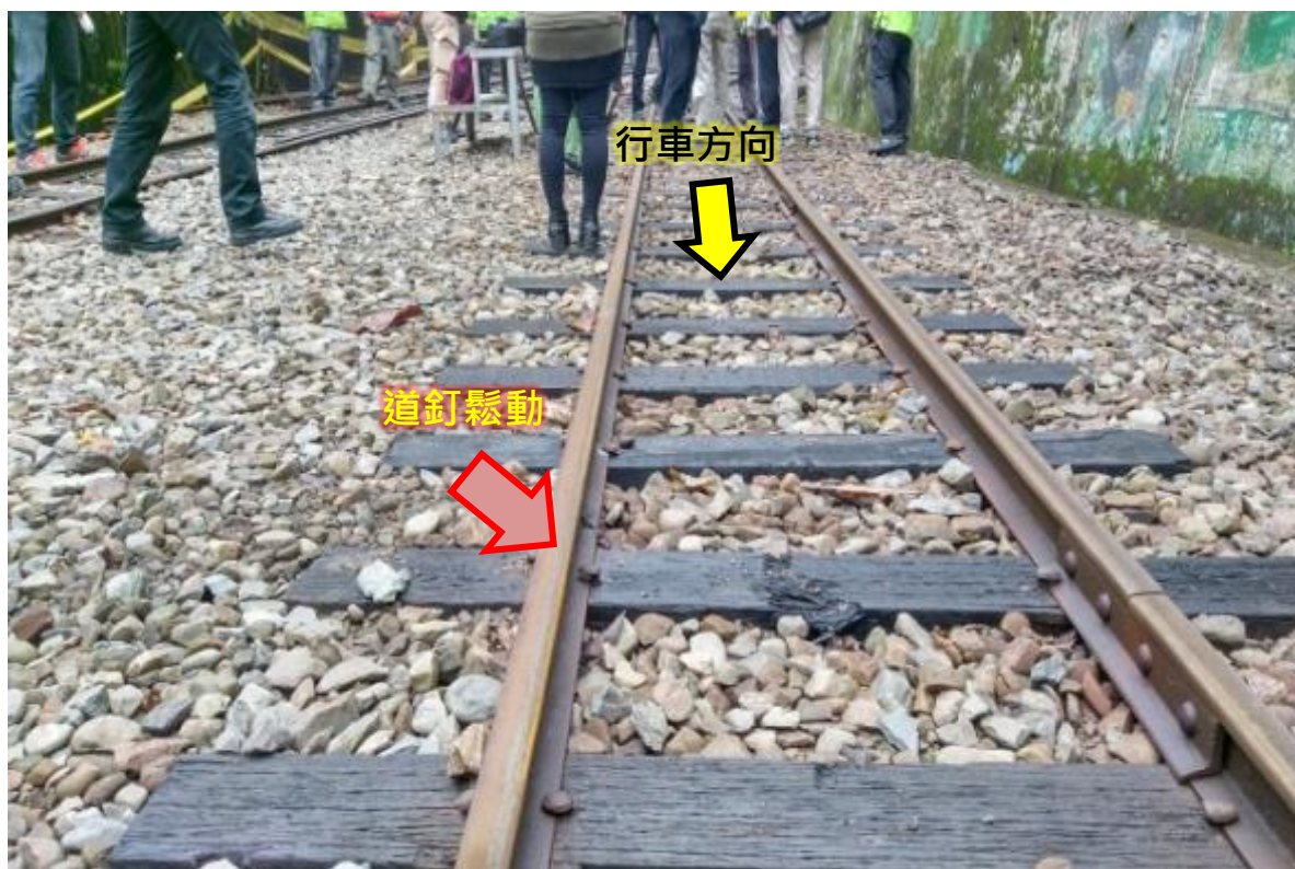
圖 3.2.1-7 軌枕壓痕及道釘鬆動
