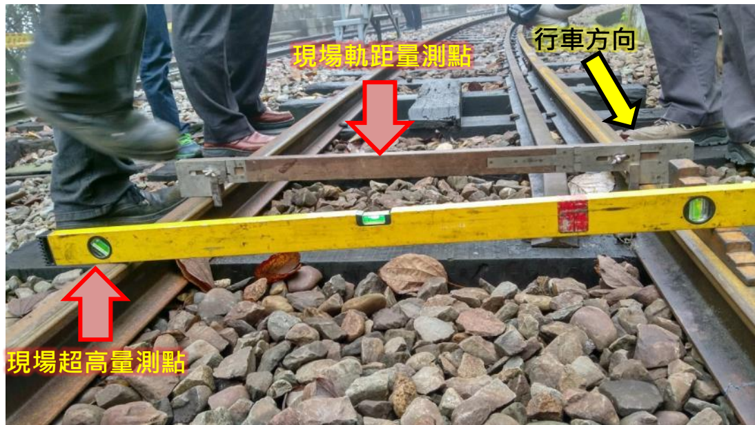
圖 3.2.1-6 現場量測超高與軌距示意
