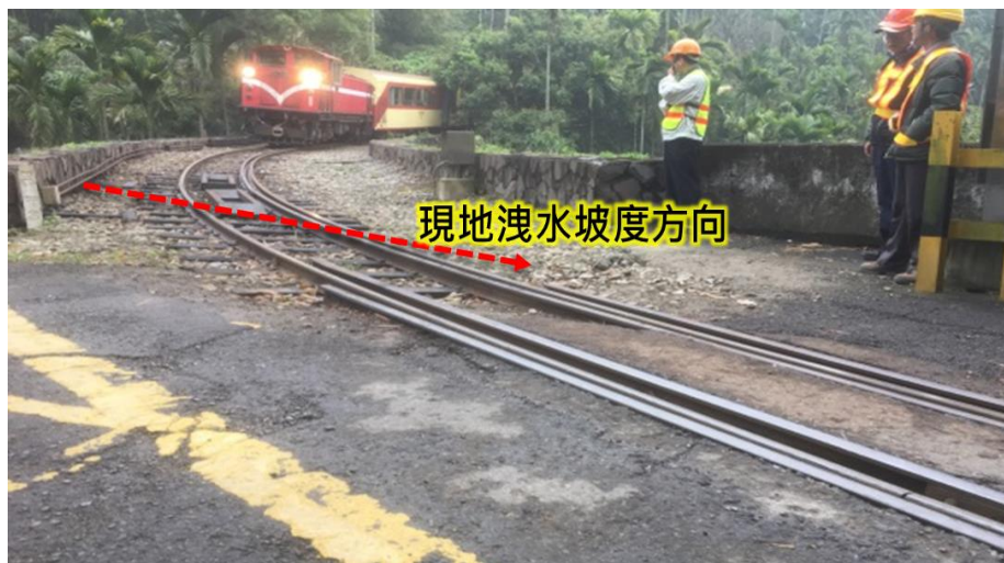
圖 3.2.1-16 現場洩水坡度示意
