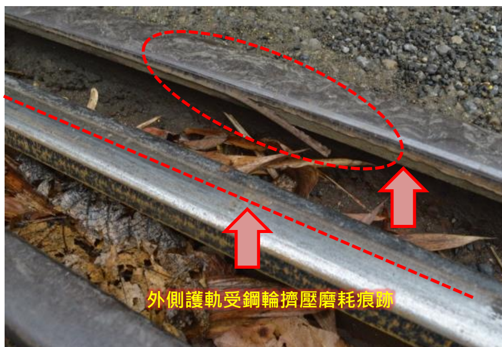
圖 3.2.1-8 事故路段軌道磨損示意
