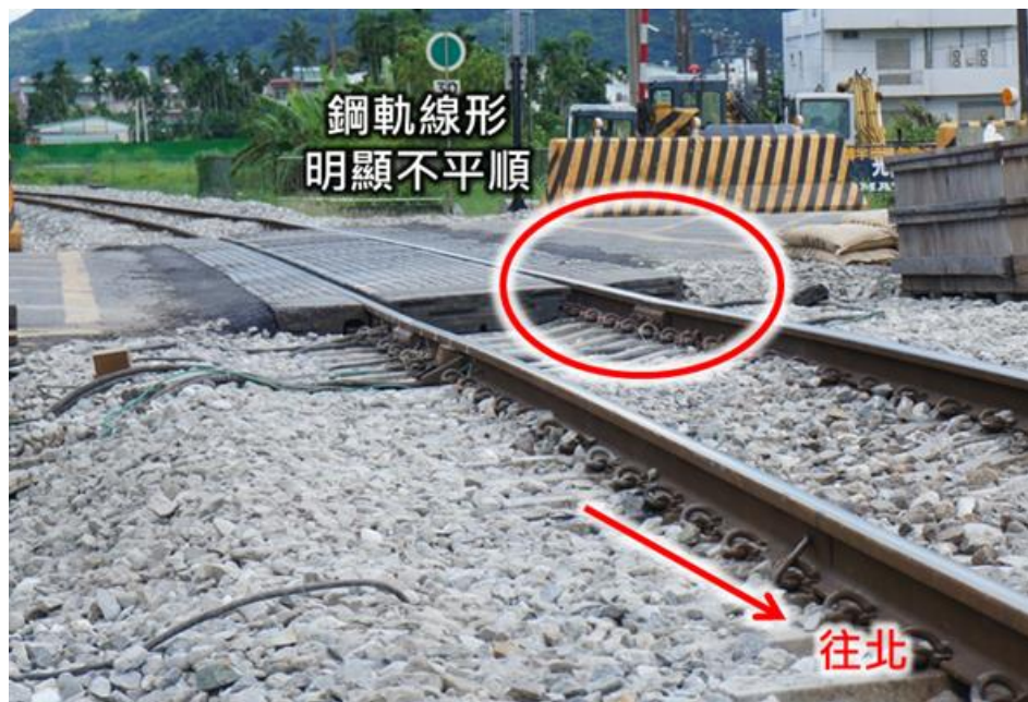
圖 3.4-14 事故次日平交道鋼軌線形
