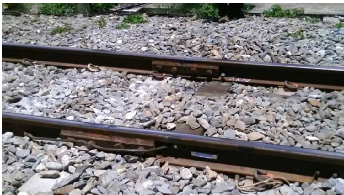
圖 2.4-3 K104+655 鋼軌夾膠絕緣接頭
