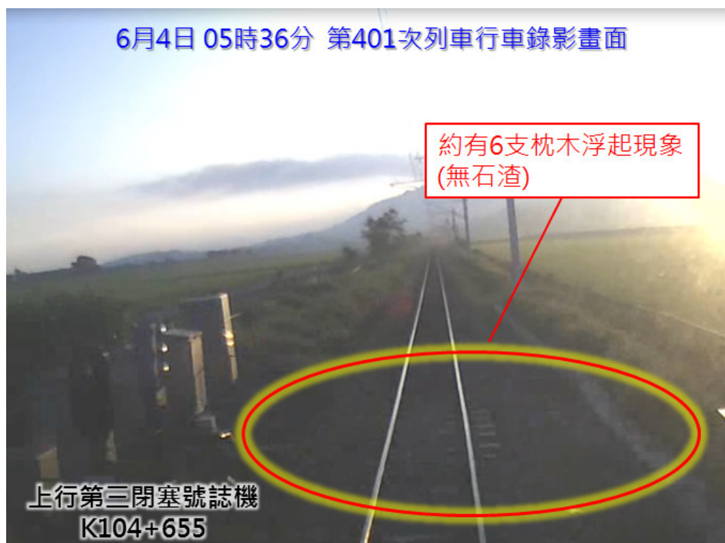
圖 2.4-5 K104+655 處 6 月 4 日抽換軌枕後之路線狀況
