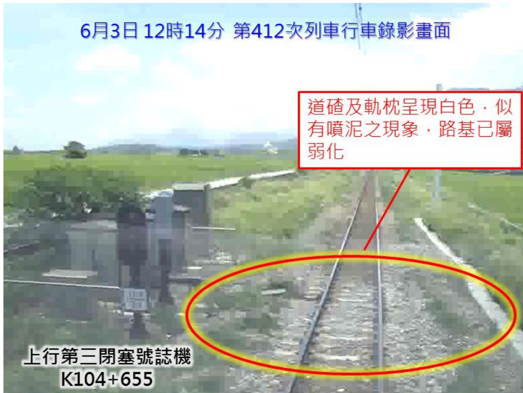
圖 2.4-4 K104+655 處 6 月 3 日抽換軌枕前之路線狀況
