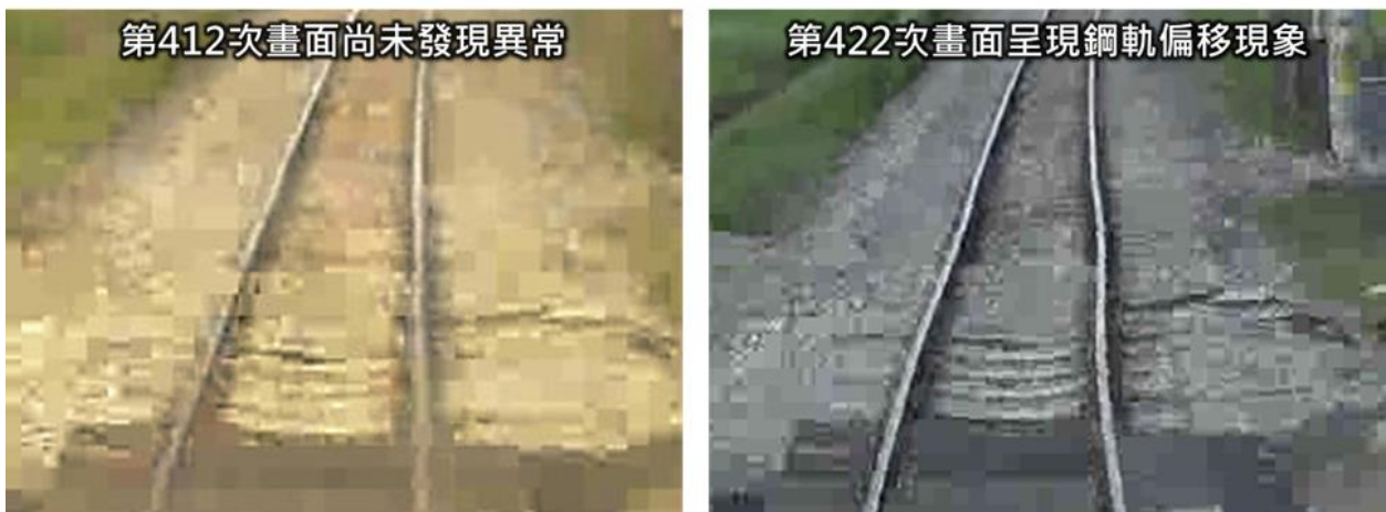
圖 3.4-9 二列車鋼軌偏移增加情形
