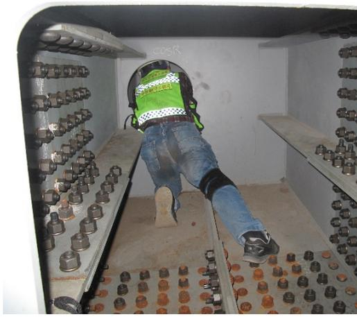
圖 59 白沙一號橋箱梁內鋼纜端錨目視
