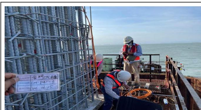
圖 45 鋼筋腐蝕計安裝
