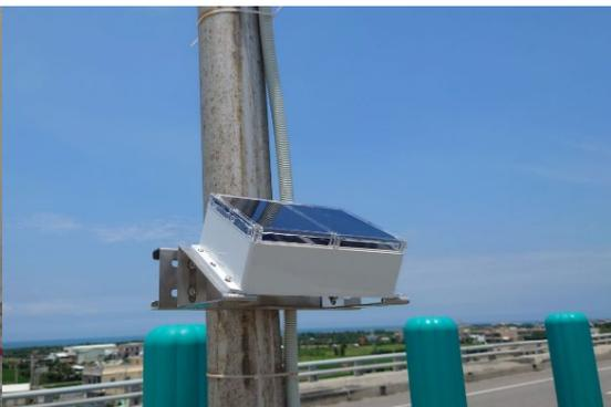
圖 72 NB-IoT 無線通訊與太陽能供電模組
