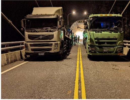
圖 57 白沙二號橋橋梁載重試驗
