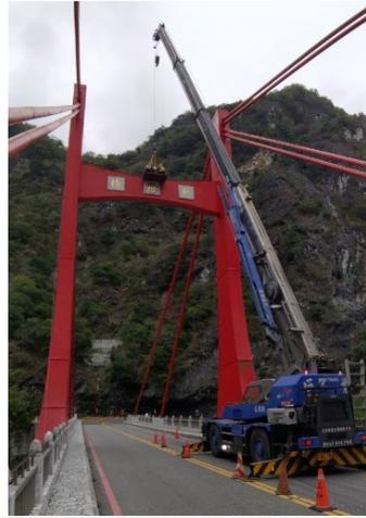
圖 60 慈母橋橋塔傾斜計安裝
