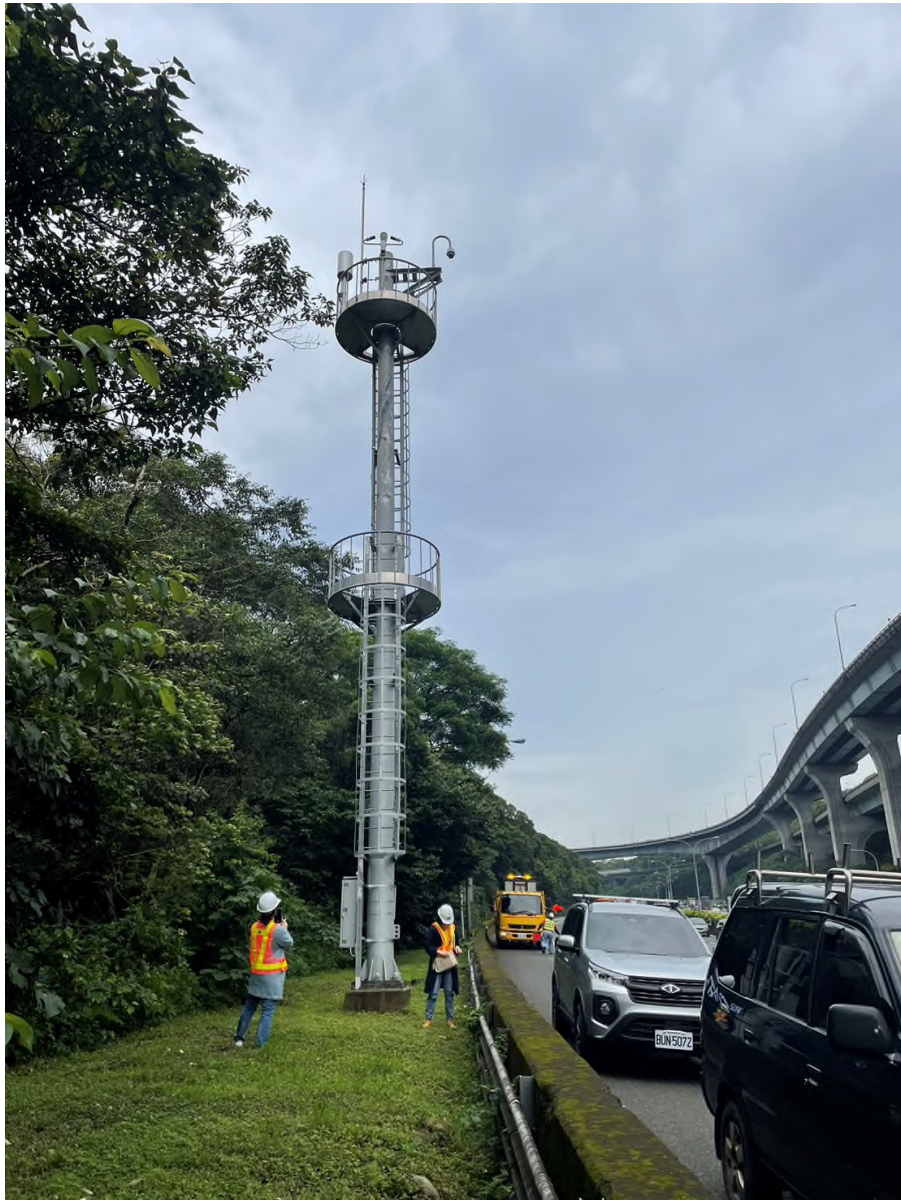
附圖 1 既設 CCTV 14 米桿上建置自動氣象站
