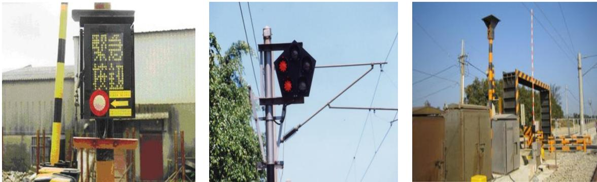
圖 2.2.2-1 緊急停止按鈕、告警號訊機、列車防護無線電
