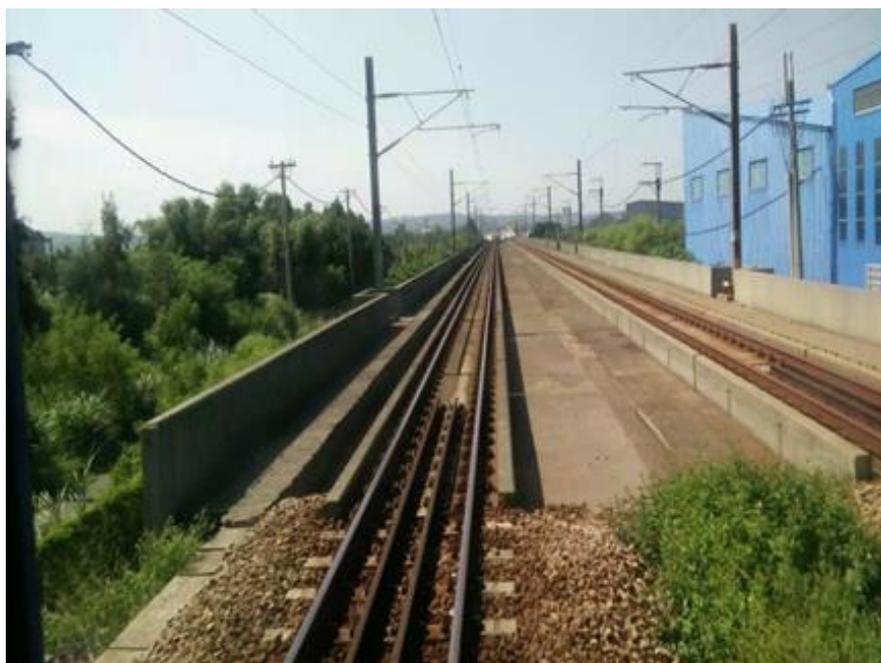
圖 3.1.2-1 防脫護軌及脫軌防護牆
