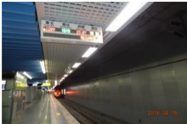
依據本局機電工程設計注意事項設置列車資訊顯示系統(TIDS)。
