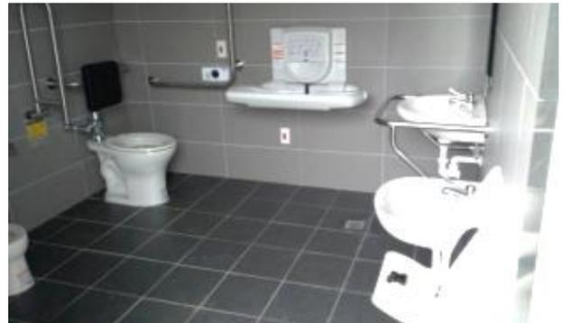
依據建築物無障礙設施設計規範設置，無障礙及親子廁所內部設備包含：便器、兒童便器、洗面盆、照面鏡、求助鈴。(圖為員林車站及豐田車站)
